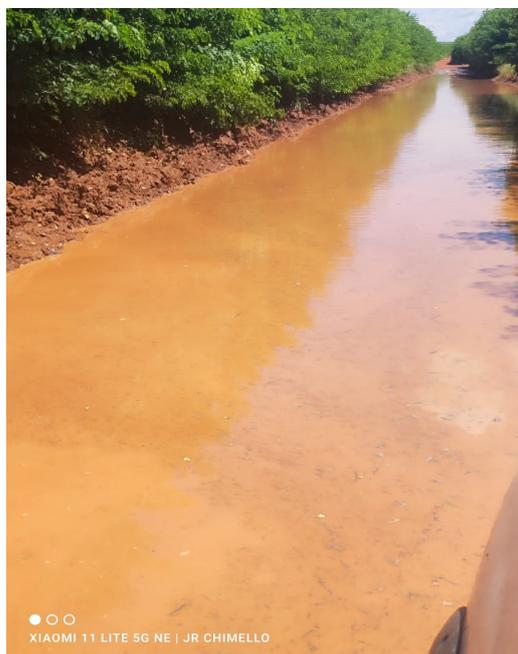
A Estrada Vicinal BBD 70 necessita urgentemente de manutenção com motoniveladora. Seu estado atual compromete a segurança e a trafegabilidade, principalmente devido ao acúmulo de água de um córrego adjacente, formando poças que dificultam a passagem de veículos e pedestres. Essa situação causa desgaste precoce da estrada, erosões e riscos, especialmente em períodos chuvosos.
