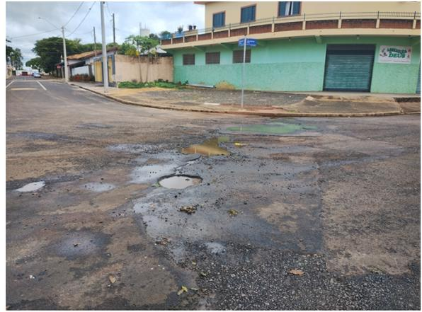
Solicito a atenção do departamento para a necessidade de construção de canaleta no cruzamento da Rua Avelino Mariotini com a Cel. Conrado Caldeira, no distrito de Botafogo. Como pode ser observado nas fotos acima, a vazão errada da água já criou uma valeta de fora a fora na via, deteriorando o asfalto, para os veículos atravessarem o local precisa de cuidado. O problema está se estendendo e criando vários buracos nas imediações, tornando o trecho perigoso e propício para acidentes.
