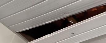
Alguns lugares já caíram completamente partes do forro e em outros há perigo de cair a placa a qualquer instante e pode atingir alguém, pois uma das salas com problemas no forro é justamente o consultório dentário. O telhado também tem danos e precisa de manutenção.
