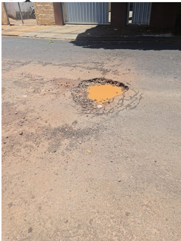
Rua Alagoas n. 51 – Jardim Marajá
