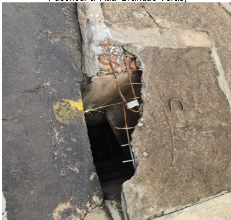
Passeio Público – Rodoviária (semáforo da Av Pedro Paschoal c/ Rua Brandão Veras)
