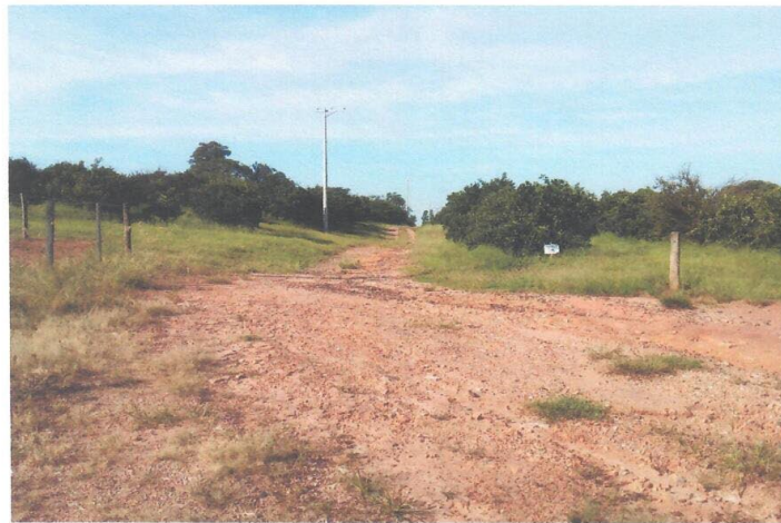
Foto 15 – Detalhe – Vista da Estrada Municipal BBD - 151 do Município de Bebedouro/SP.
