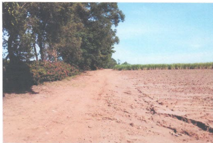
Foto 13 – Detalhe – Vista da Estrada Municipal BBD – 475 do Município de Bebedouro/SP.
