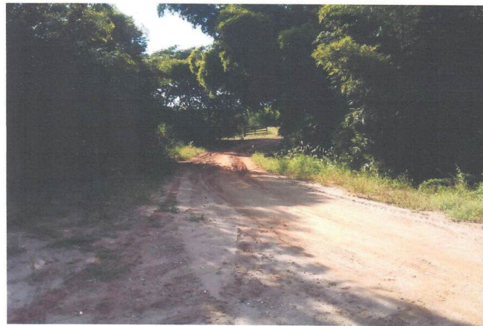
Foto 11 – Detalhe – Vista da Estrada Municipal BBD – 151 do Município de Bebedouro/SP.
