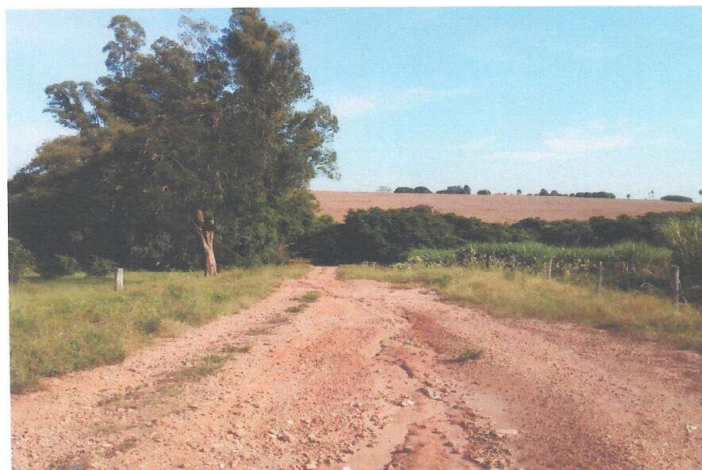
Foto 13 – Detalhe – Vista da Estrada Municipal BBD – 151 do Município de Bebedouro/SP.
