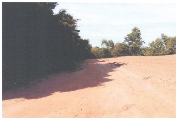
Foto 17 – Detalhe – Vista da Estrada Municipal BBD – 475 do Município de Bebedouro/SP.
