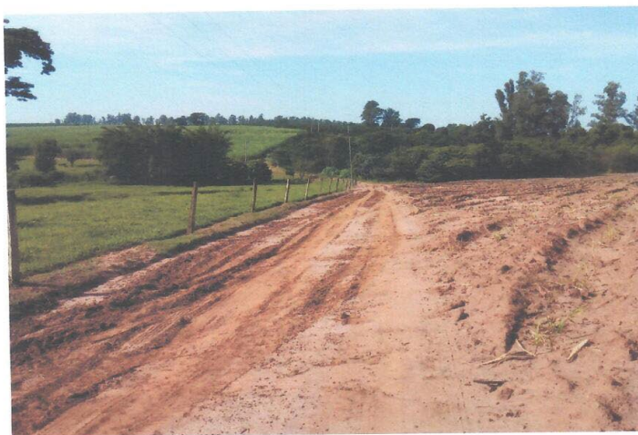
Foto 09 – Detalhe – Vista da Estrada Municipal BBD – 151 do Município de Bebedouro/SP.
