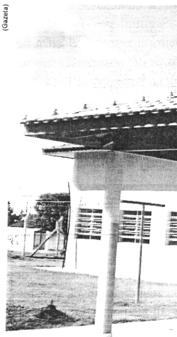
Accesibilidadad Prédio adaptado
