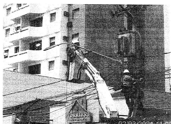
Detalhe da instalação das luminárias LED no entorno das Praças Barão Rio Branco e Monsenhor A. S. Leite
