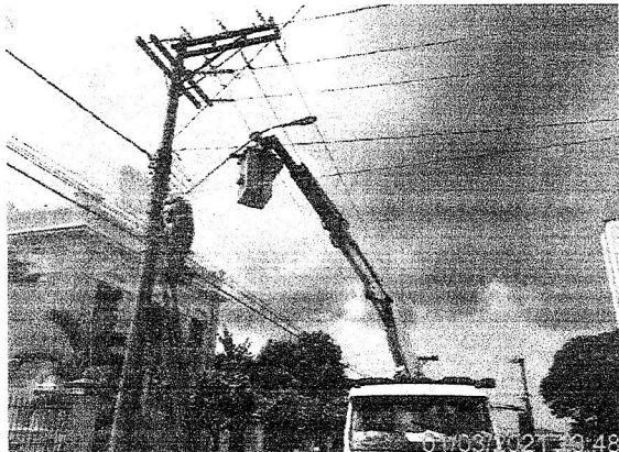
Detalhe da instalação das luminárias LED no entorno do Paço Municipal e Praça Valencio de Barros
