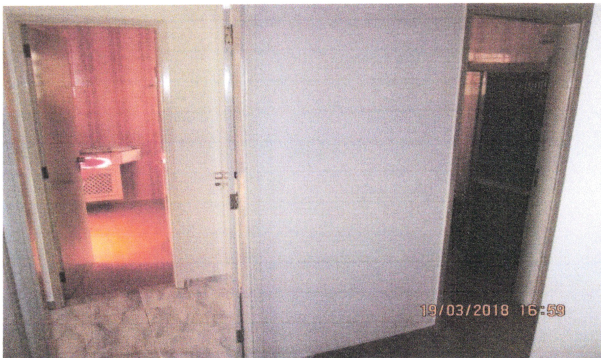
FOTO 13 – Fim do corredor da copa, com vista para porta dos banheiros.
