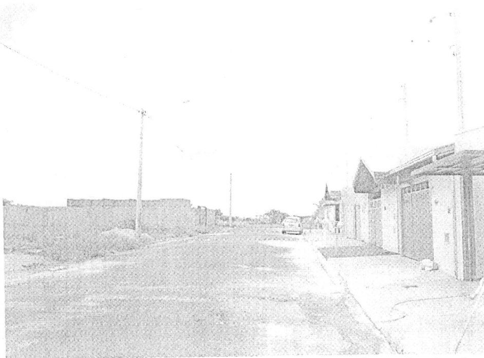
Foto 05 – Vista parcial da Alameda Nicanor Pereira Maia com iluminação pública
