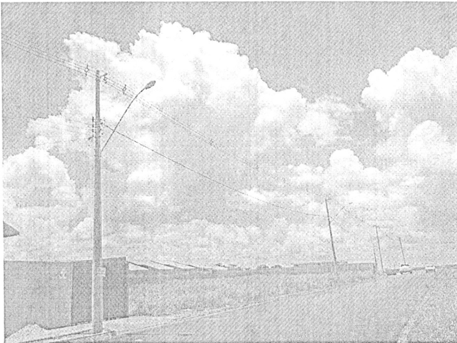
Foto 04 – Vista parcial da Alameda Raimundo Ruzante com iluminação pública
