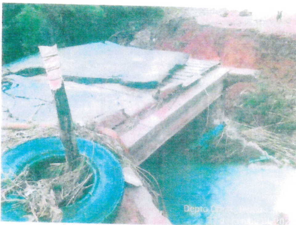
FOTO 5: Visão do aterro da Ala direita destruído
