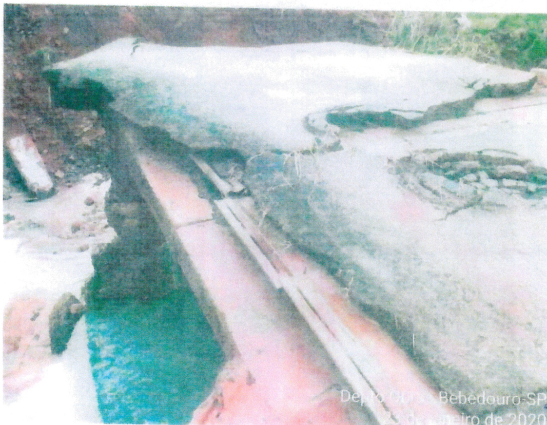
FOTO 2 – Vista do capeamento asfáltico sobre a ponte destruído
