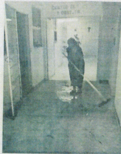
Parte do Hospital Municipal em dependências invadidas pela água
