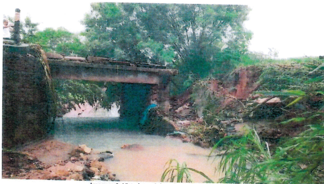
Imagem 1: Vista lateral da ponte - Data 23/01/2020
