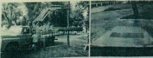
Retirada da árvore inclinada e reparo na rampa de acessibilidade na Praça Carlos Gomes
