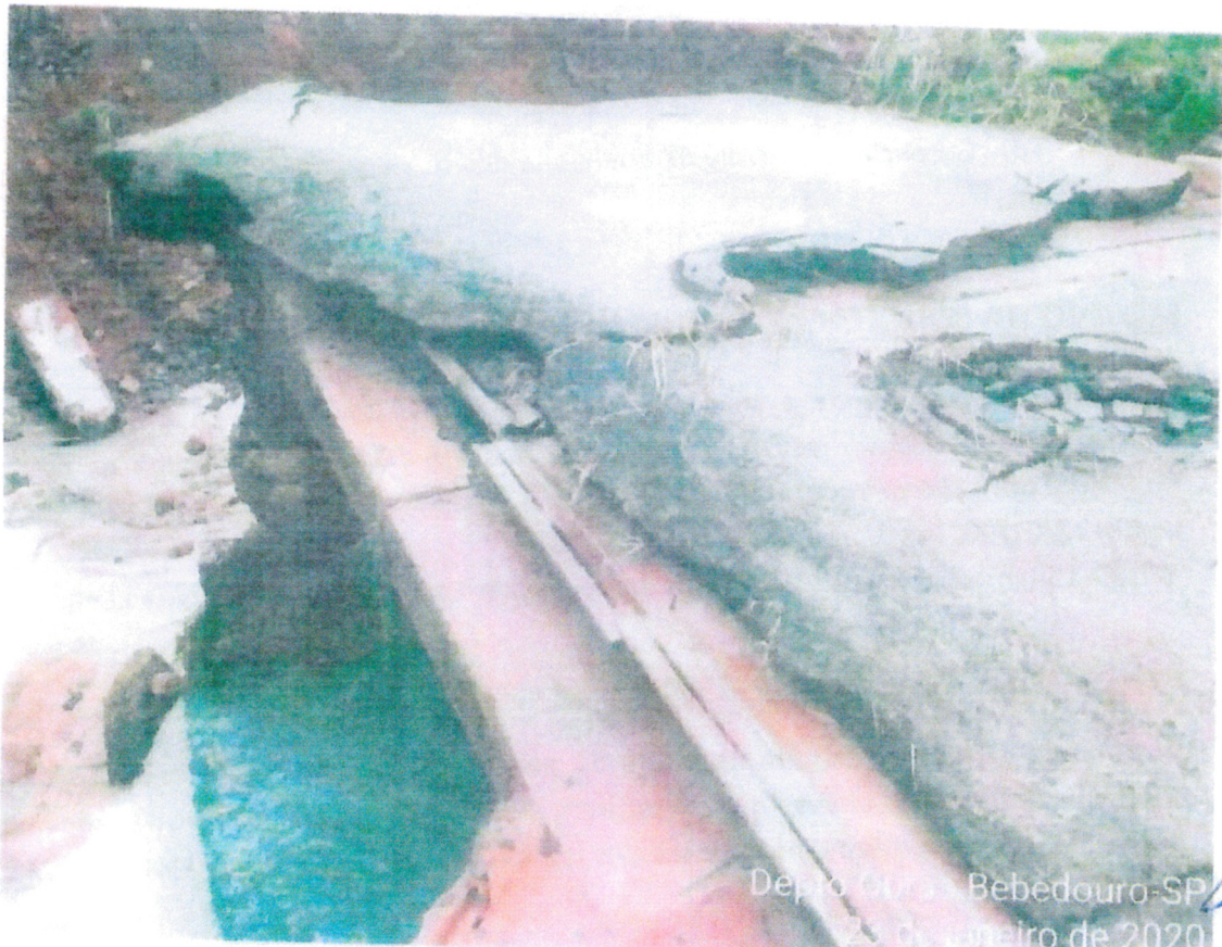
FOTO 2 – Vista do capeamento asfáltico sobre a ponte destruída
