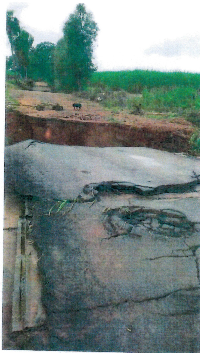
Imagem 3: Asfalto danificado
