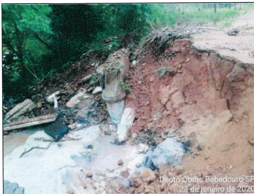
Ponte Vicinal Lourenço Santin - Acessos 376a e b
