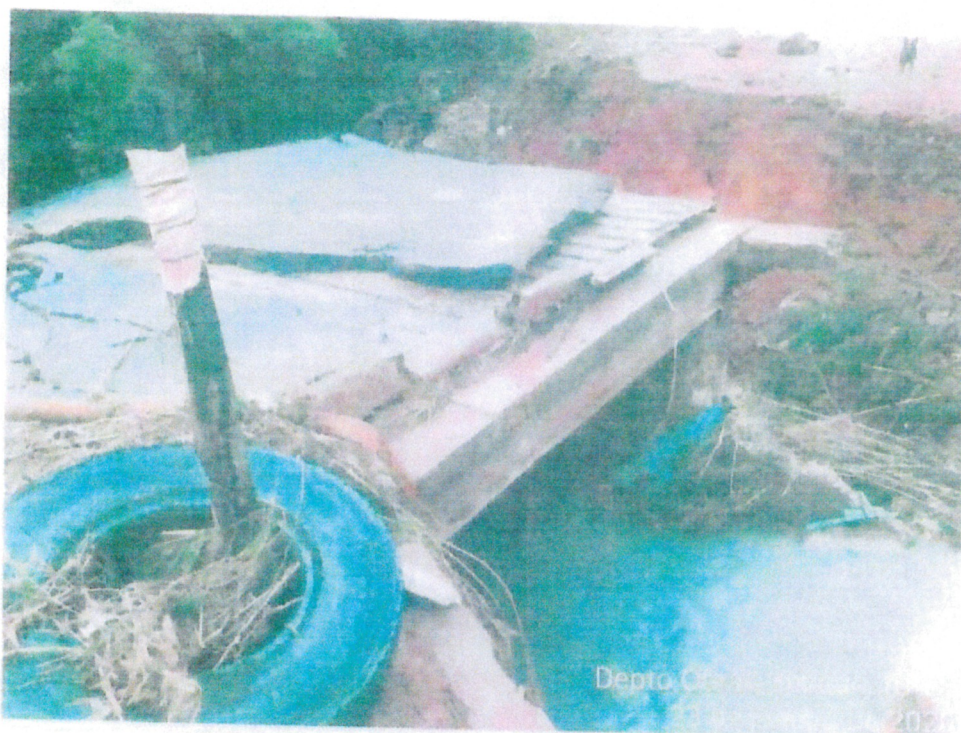
FOTO 5: Visão do aterro da Ala direita destruído
