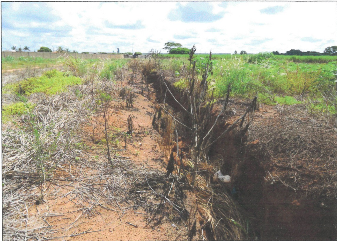
Foto 04 – Vala executada no solo natural para o escoamento das águas provenientes da rodovia e da parte das ruas do bairro localizado do outro lado da rodovia.
