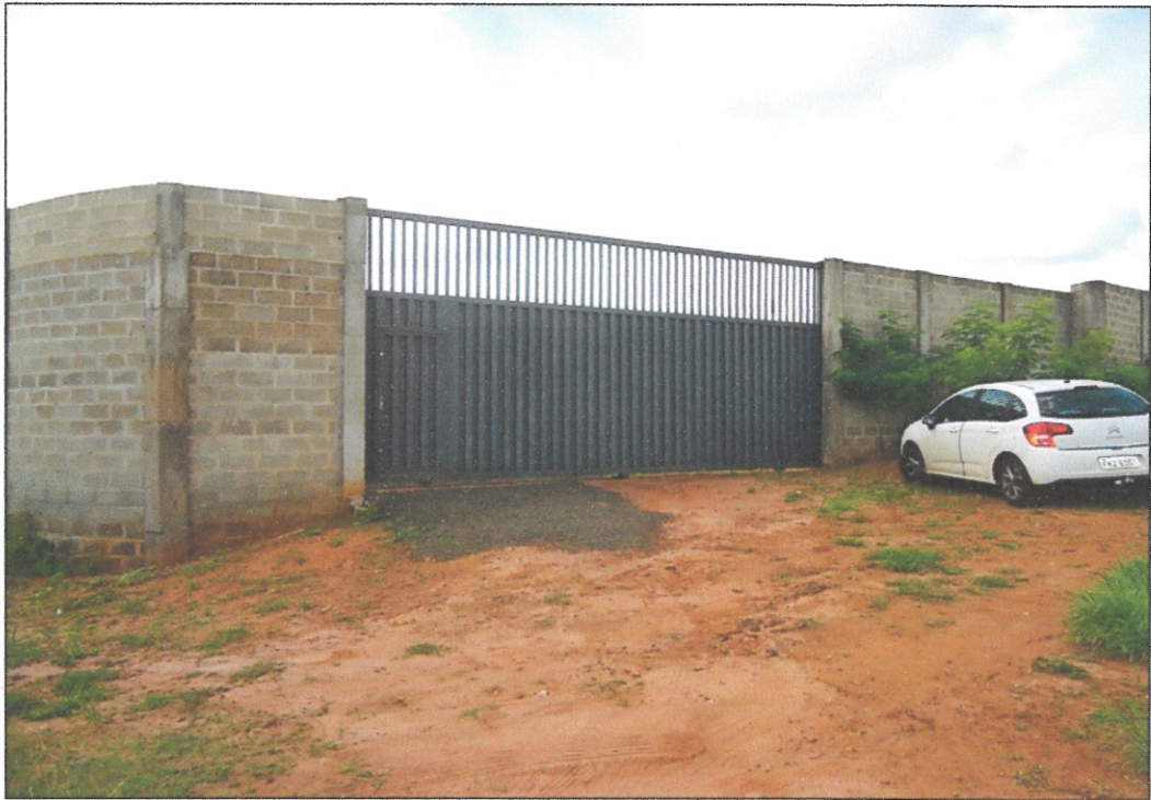
Foto 02 – Detalhe do portão de correr para o acesso dos veículos
