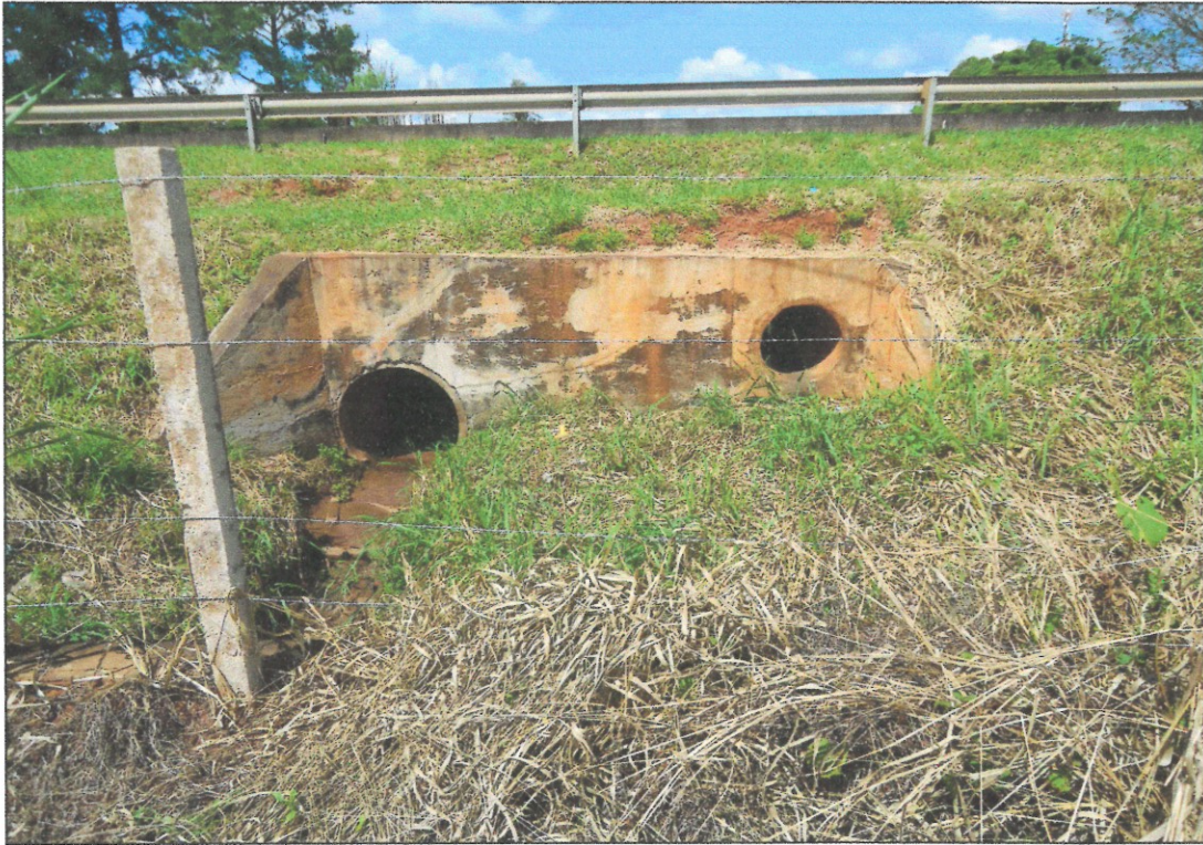
Foto 03 – Ponto de descarga das águas pluviais provenientes da rodovia e de algumas ruas do bairro localizado do outro lado da rodovia
