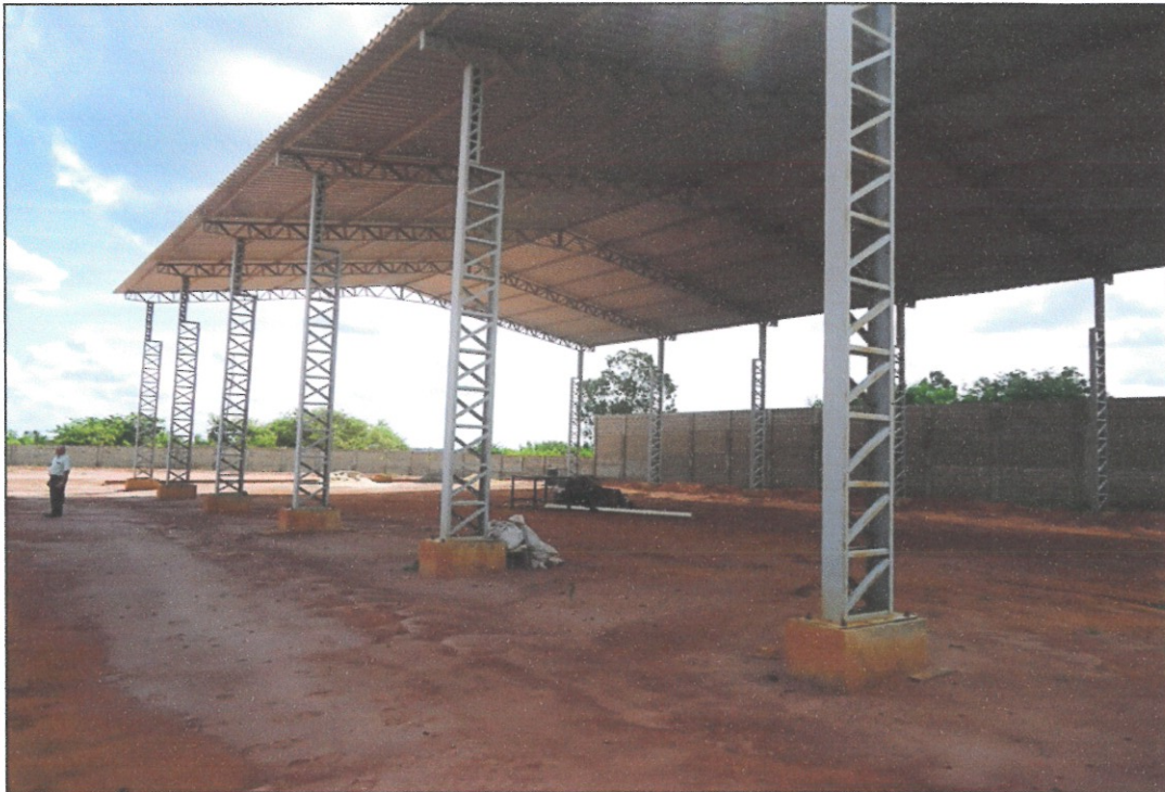
Foto 06 – Detalhe dos pilares e das tesouras do Barracão.
