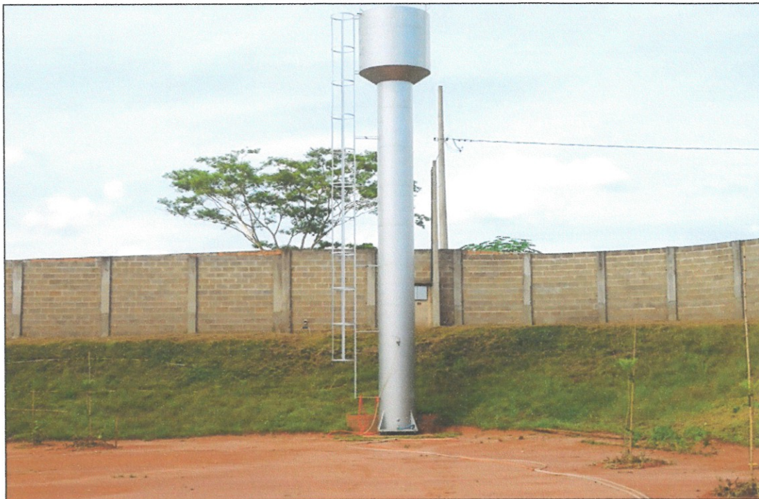
Foto 04 – Detalhe do Reservatório
