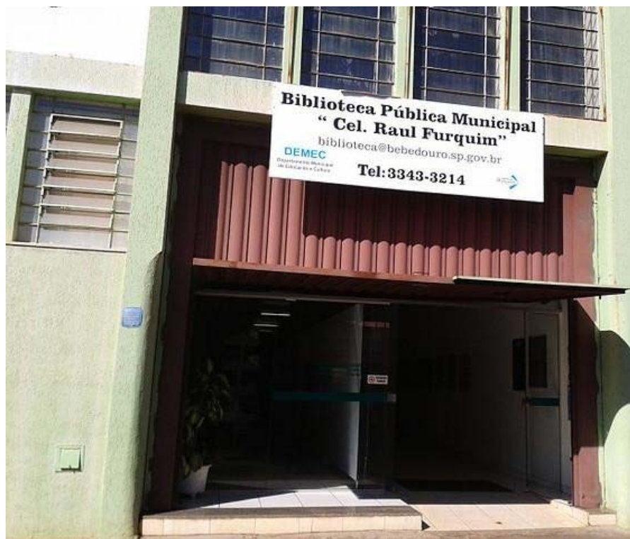
Foto 8- Vista Frontal da Biblioteca Municipal
