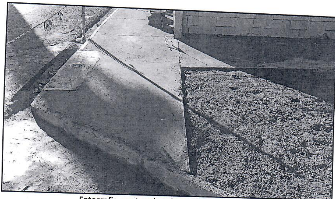
Fotografia mostrando a água pluvial executada
