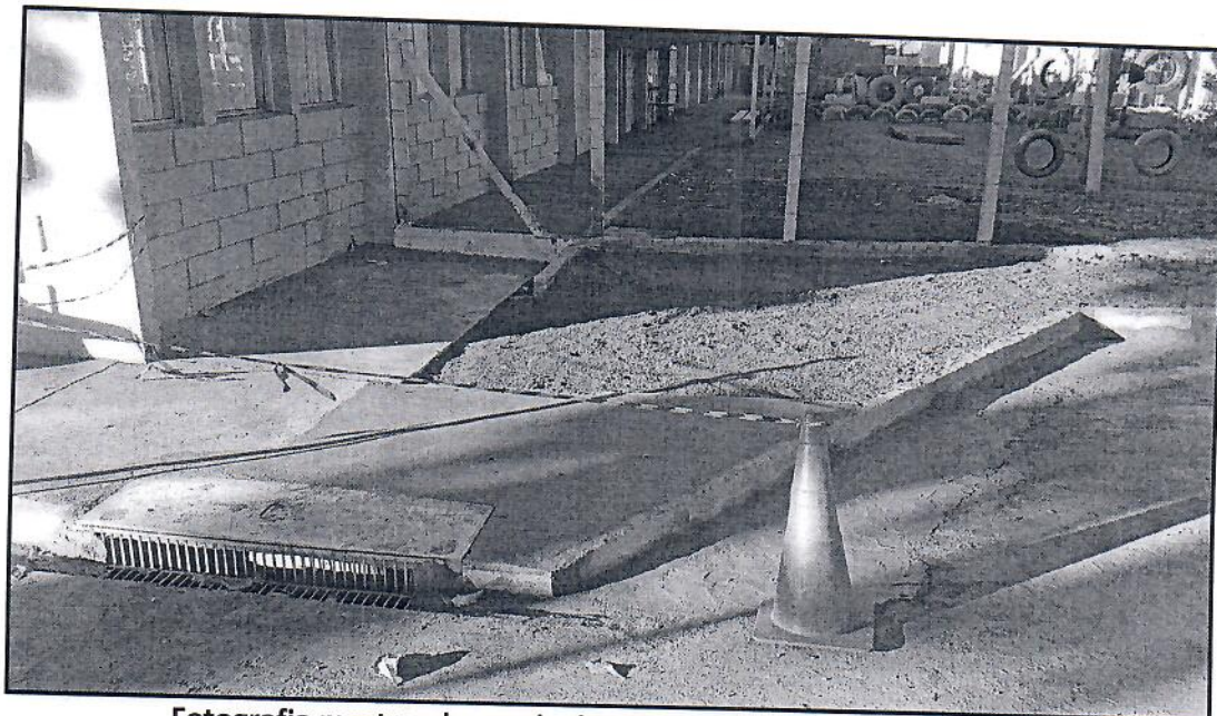
Fotografia mostrando a rede de esgoto e água pluvial executado
