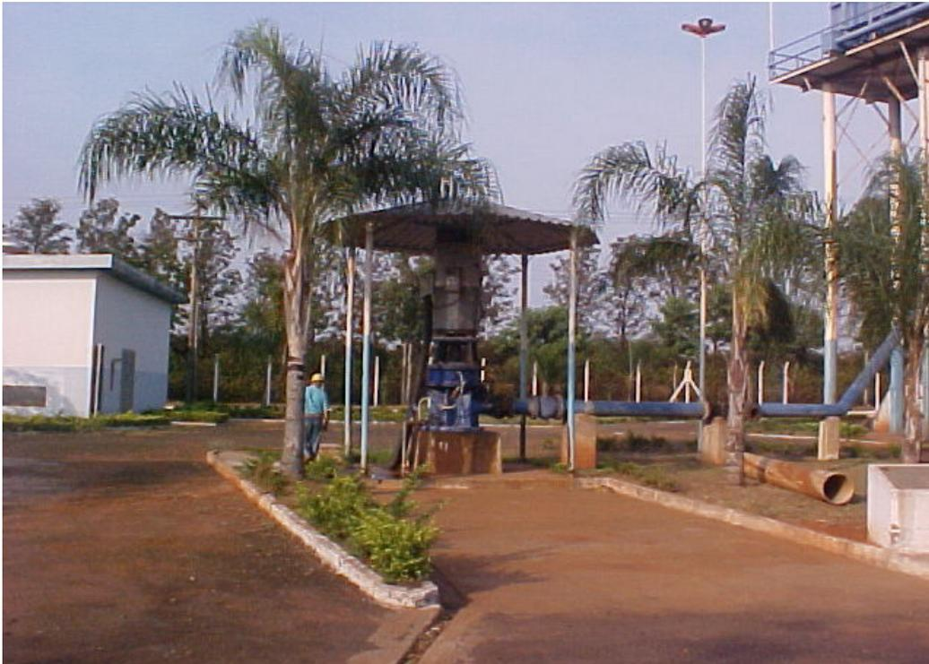
*Bomba de eixo prolongado – Poço P1*
