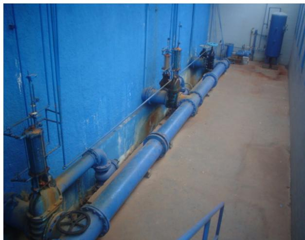
*Sistema de acionamento hidráulico ETA 2*
