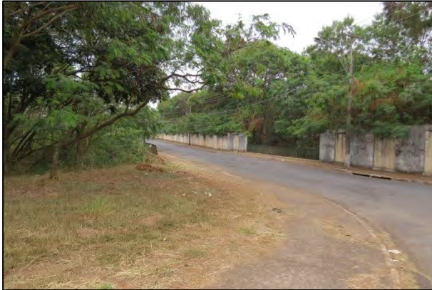
Foto 33. Vista de ponte localizada na rua Lucas Evangelista. A ponte foi reconstruída a partir do acidente registrado em 2006 com registro de óbito.
