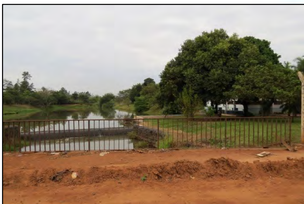
FOTO 31. Vista, de jusante para montante, do lago e do guarda corpo da ponte para proteção de pedestres e veículos.
