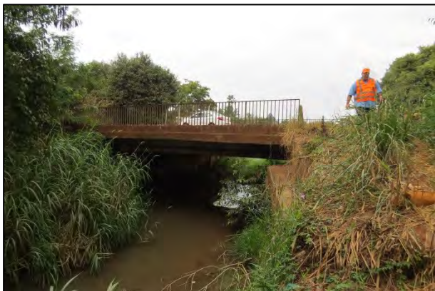
FOTO 29. Vista de ponte redimensionada, a partir das inundações ocorridas no ano de 2006. Notar vão central e proteções das cabeceiras. As obras foram financiadas pela Coordenadoria Estadual de Defesa Civil.
