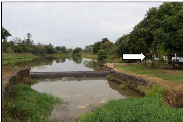
FOTO 25. Vista, de jusante para montante, do lago utilizado para acúmulo e captação de água – CAP2 (seta). Nesse local ocorrem inundações e extravasamentos do lago. Esse ponto está localizado a montante do ponto vistoriado e mostrado na FOTO 24 .
