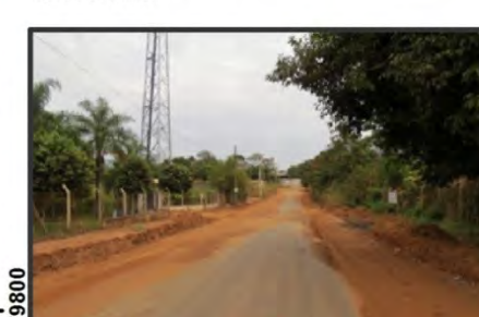
Vista de trecho da variante Lourenço Santim afetada pelas inundações. Segundo dados da Compdec as águas podem atingir 2 m de altura.
