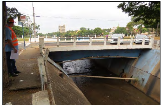
FOTO 20. Vista, de jusante para montante, de travessia do córrego Bebedouro, nas proximidades da rua São João e tomada d'água do Lago Artificial.
