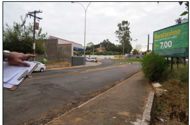
FOTO 4. Vista do muro derrubado quando da inundação do córrego Vidal datada de 31/01/2017.
