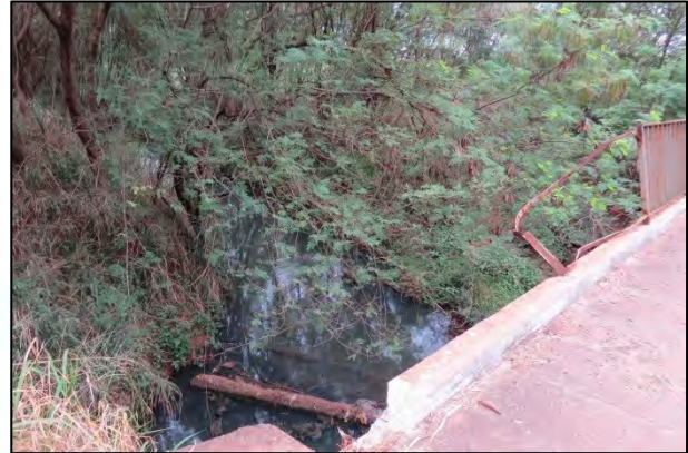
Foto 34. Vista de trecho do córrego Bebedouro e partes da antiga ponte (seta). Segundo informações da Compdec a antiga ponte obstruía o escoamento das águas e potencializava as inundações. Há possibilidade, também, de geração de processos mais impactantes tipo enxurradas.
