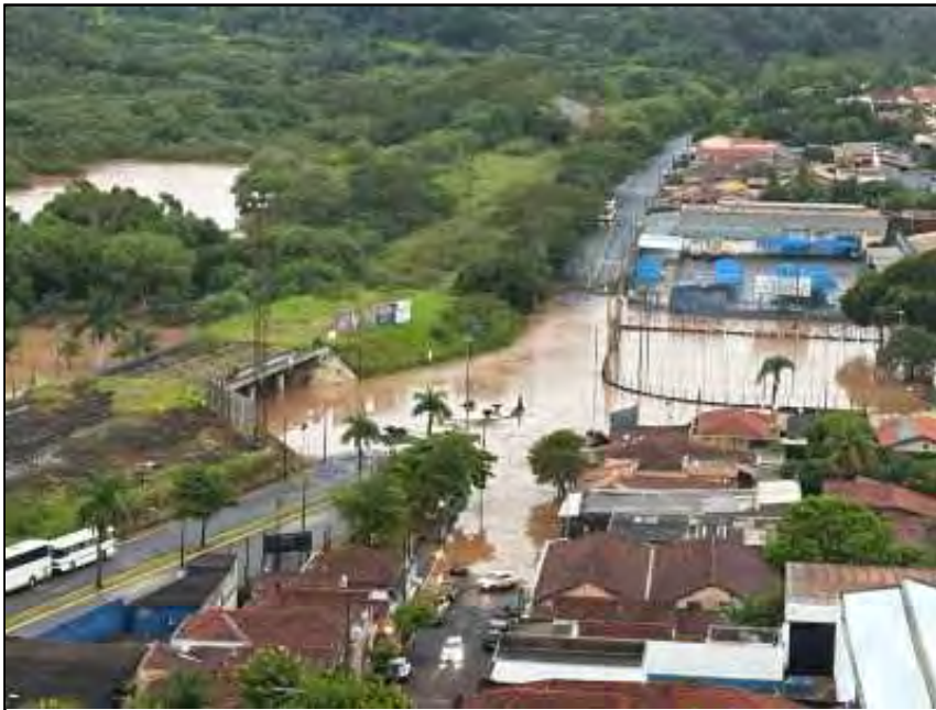
Ponte da Fepasa com 2 metros de água
