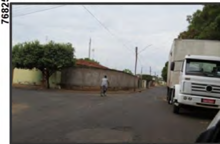
Vista de trecho e moradias afetadas pelas inundações do córrego Bebedouro.
