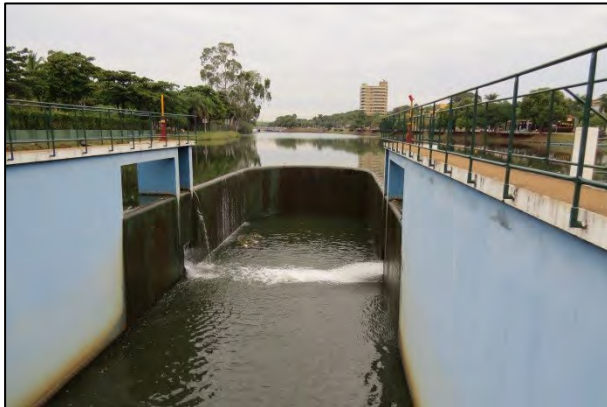
FOTO 13. Vista da tomada d'água do Lago Artificial, nas proximidades da rua São João e Avenida Sérgio Sessa Stamato. Notar dimensões e geometria da tomada d'água.
