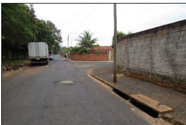
Foto 43. Vista de "boca de lobo" (sem gradil) responsável pela coleta das águas que escoam nas vias de acesso (Avenida Dr. Antônio Honório da Fonseca e Castro Neto). Segundo informações locais, esse sistema pode funcionar como condutores das águas do córrego por meio de tubulações que se encontram no canal.
