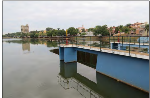
FOTO 14. Vista lateral da tomada d'água localizada no Lago Artificial. Ao fundo, Avenida Sérgio Sessa Stamato. Notar dimensões do lago e altura dos taludes laterais.
