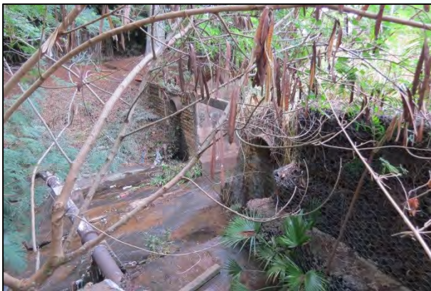
FOTO 11. Vista das obras de contenção executadas durante a ampliação do canal. Notar tubulação de água que cruza o eixo do córrego Bebedouro.
