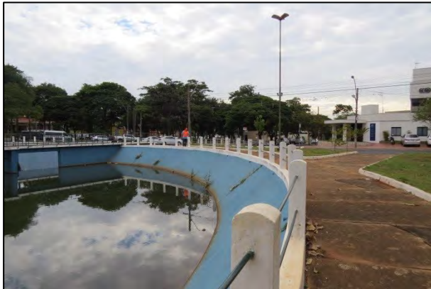
FOTO 17. Vista de trecho da rua São João e taludes laterais do Lago Artificial. As inundações ocorridas nos anos de 1986 e 2006 superaram as margens do lago e provocaram danos a jusante.
