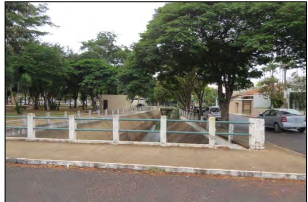
FOTO 18. Trecho canalizado do córrego Bebedouro, a poucos metros da tomada d'água do Lago Artificial, Trata-se de trecho canalizado (seção trapezoidal) até as proximidades do encontro com o ribeirão Consulta. Nesse setor, moradias e Museu são afetados pelas inundações.
