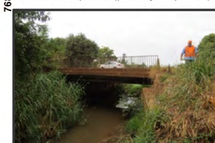
Vista de ponte redimensionada, a partir das inundações ocorridas no ano de 2006. Notar vão central e proteções das cabeceiras.
