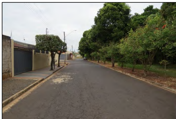
Foto 42. Vista geral da via de acesso e moradias afetadas pela inundação do córrego Bebedouro (localizado na direita da imagem). As moradias e a Avenida Dr. Antônio Honório da Fonseca e Castro Neto encontram-se na margem direita do córrego.
