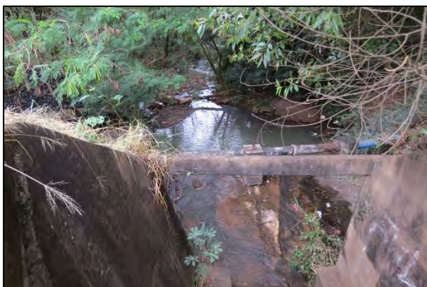
FOTO 7. Vista, de montante para jusante, a partir do ponto mostrado na FOTO 2. Notar dimensões do córrego Bebedouro, pequenas porções de areia e cascalho depositados no leito (assoreamento) e tubulação de água que cruza a drenagem.
