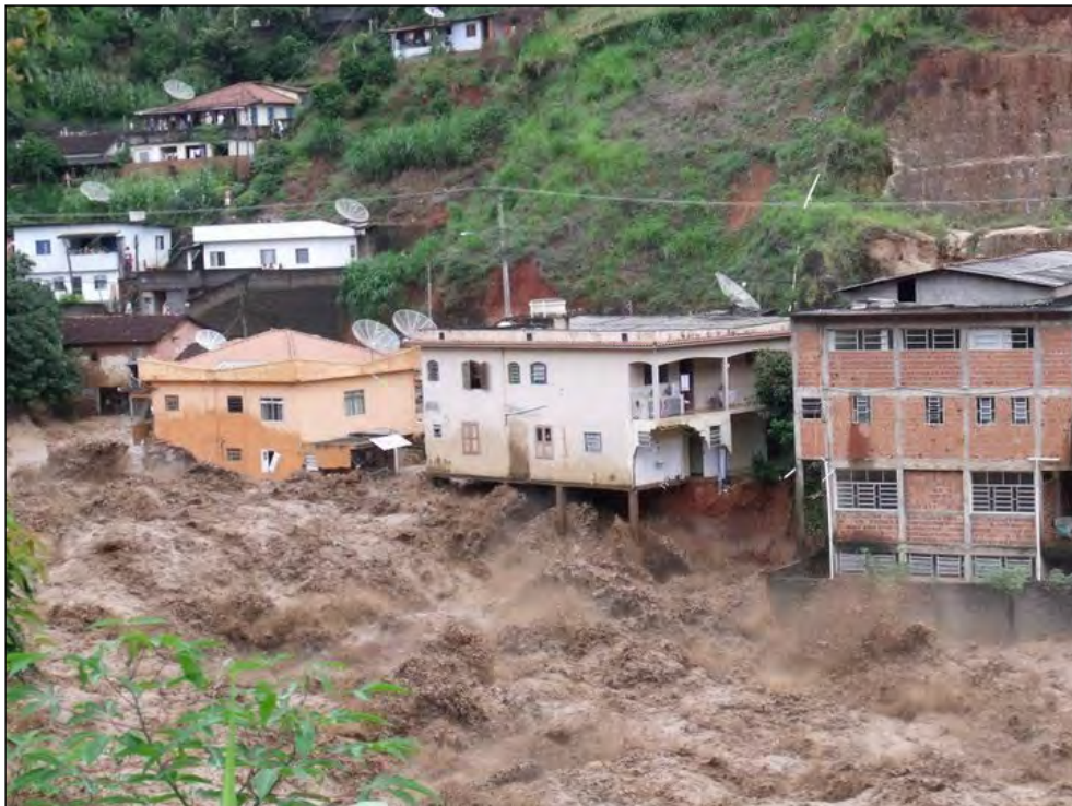
Figura 16 – Situação de enchente em um canal de drenagem (Ministério das Cidades, Instituto de Pesquisas Tecnológicas do Estado de São Paulo – IPT, 2007).
