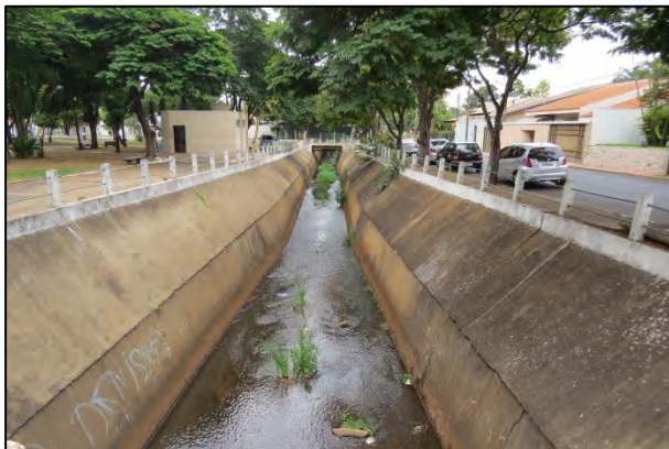
FOTO 19. Vista geral do trecho canalizado do córrego Bebedouro. Notar moradias na margem direita. Ao fundo, Museu "Eduardo André Matarazzo" e praça Santos Dumont.
