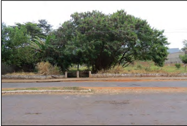
FOTO 1. Vista geral, do trecho da Av. Reverendo José Manuel da Conceição, atingida por eventos de inundação do córrego Vidal. Notar a estação de tratamento de esgoto a esquerda, afetada por eventos inundação do córrego Vidal.
