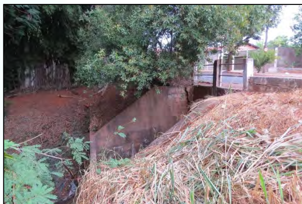
FOTO 8. Vista da ponte, com destaque para sua dimensão e proteção da cabeceira direita.
