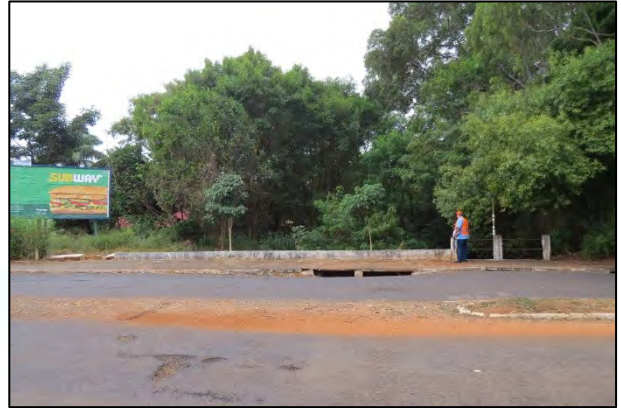
FOTO 2. Vista geral, do trecho da Av. Reverendo José Manuel da Conceição, atingida por eventos de inundação do córrego Vidal. Notar o muro da estação de tratamento de esgoto, afetada por eventos inundação do córrego Vidal.
