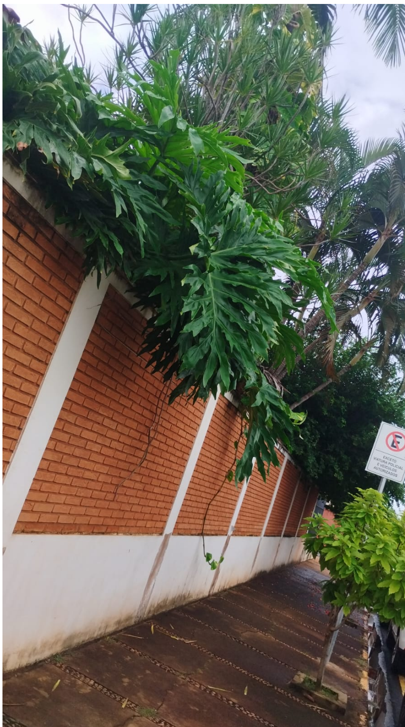
Rua Vanor Junqueira Franco, nº 999
