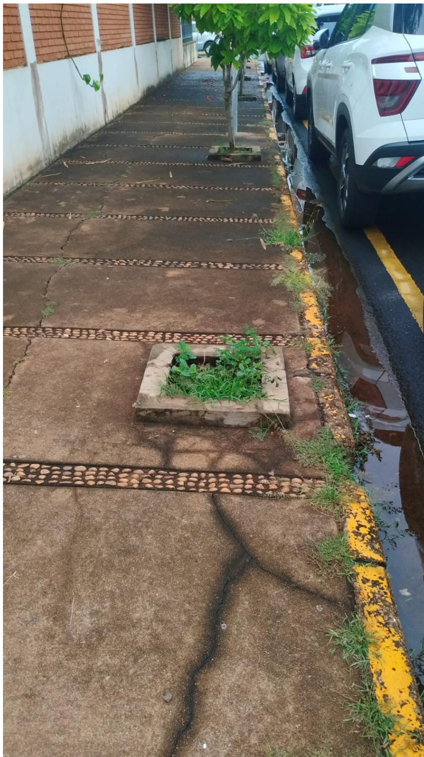
Rua Vanor Junqueira Franco, nº 999
