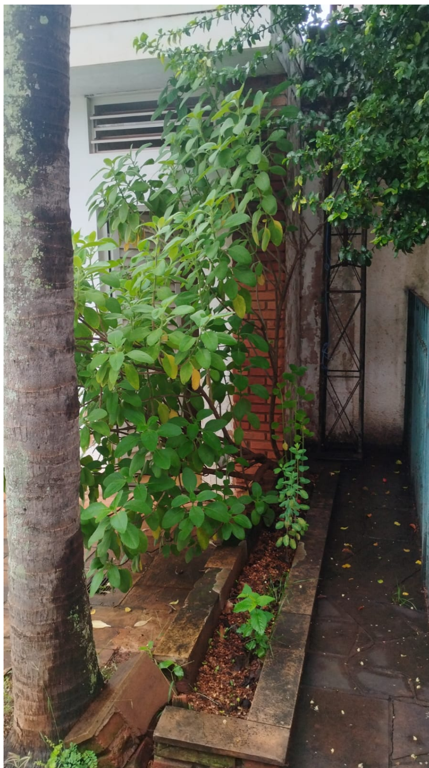
Rua Vanor Junqueira Franco, nº 999
