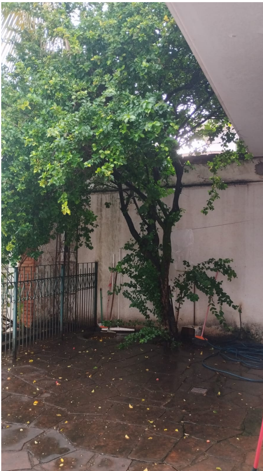
Rua Vanor Junqueira Franco, nº 999
