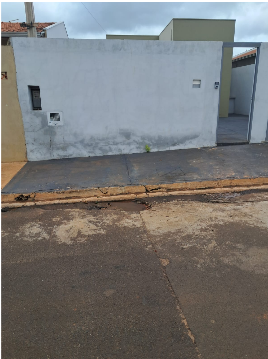
Alameda Cananeia em frente ao nº 301, acúmulo de água e a degradação do pavimento.
