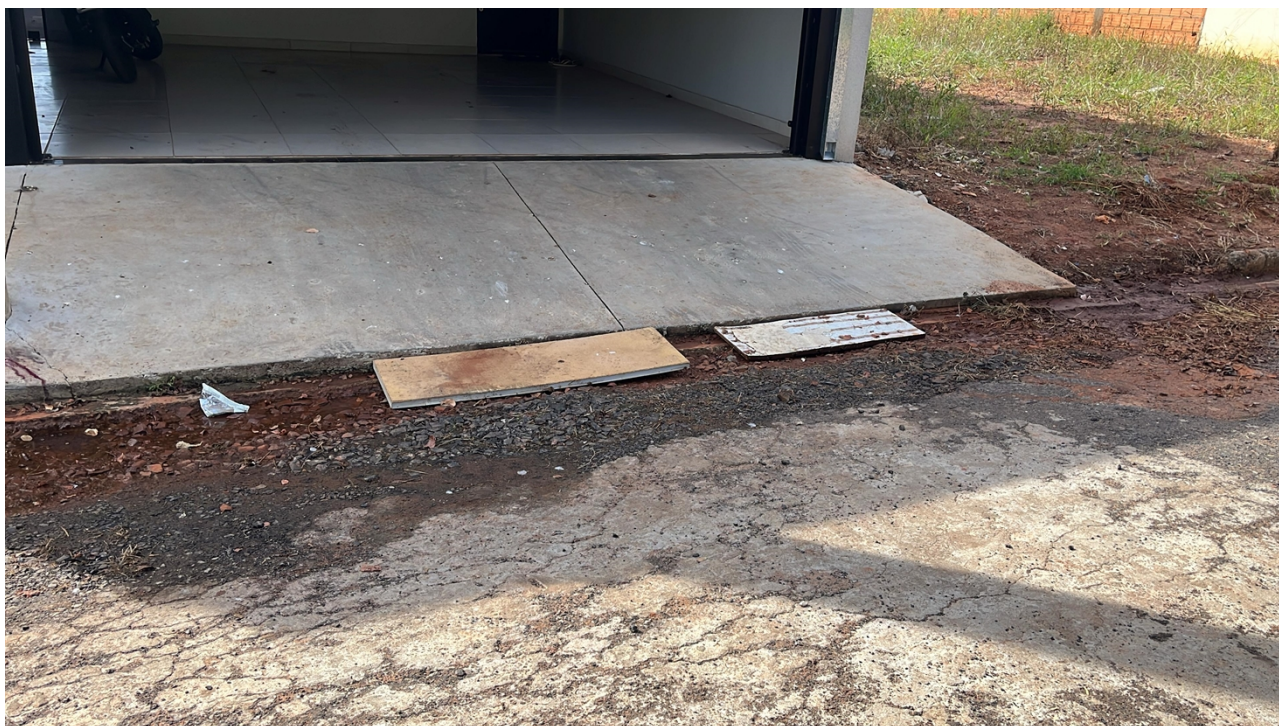
AVENIDA JOSÉ MÁRIO FERREIRA LIMA, PRÓXIMO AO Nº 175 – PARATI III
