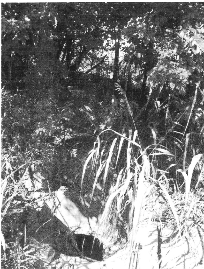
XXXI) Toda linha de drenagem de água pluvial foi desviado da estrada e jogado para o interior da propriedade que devido a intensidade da água não suportou a junção dos tubos e esta estourado logo no primeiro suspiro.
