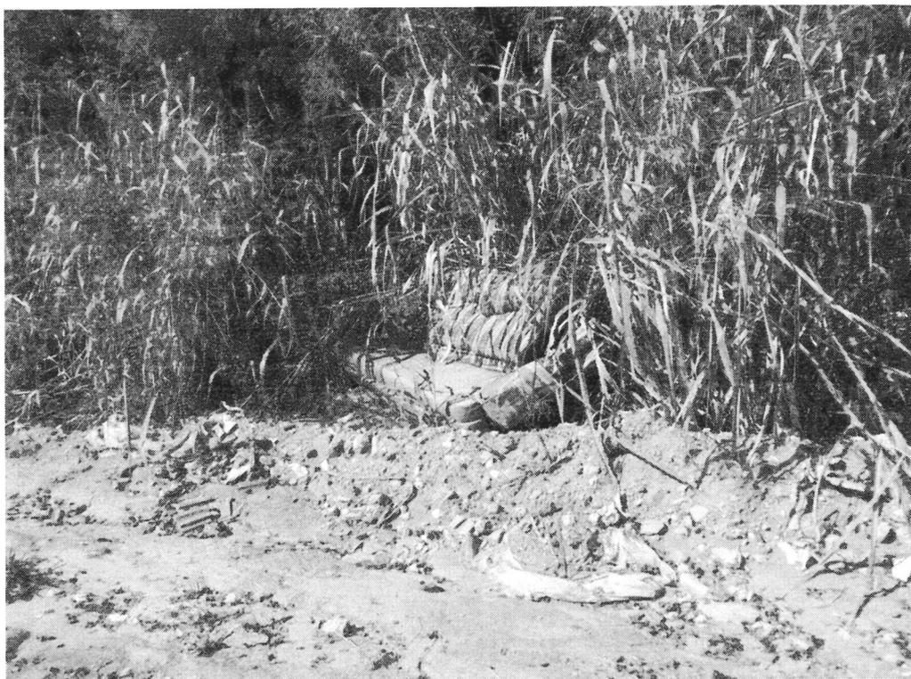
XXX) Captação de água pluvial onde é observada a ausência de tampa para evitar carreamento de garrafa pet e outros materiais para o sistema de drenagem.
