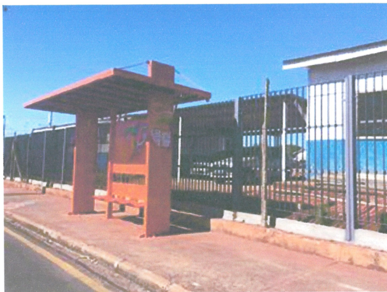
Figura 16: Ponto de ônibus, localizada na frente do imóvel, na Avenida José Cutrale Júnior.
