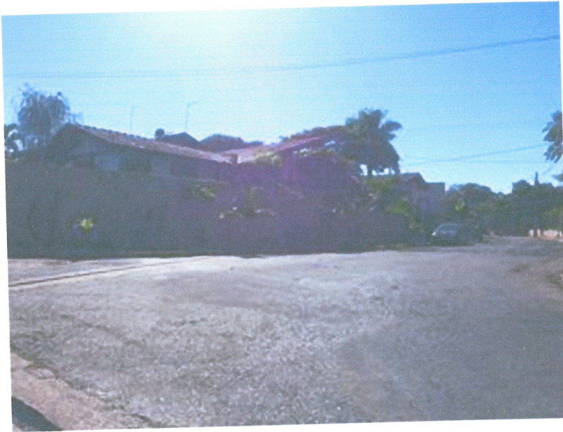
Figura 5: Loteamento Residencial fechado, localizado a 70,00 metros da área na Rua Miguel Stamato.
