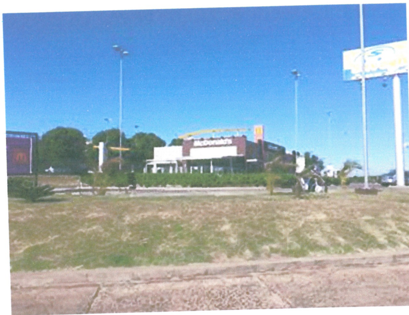
Figura 6: Mc Donald's, localizado a 45,00 metros da área na Avenida Alan Kardec.
