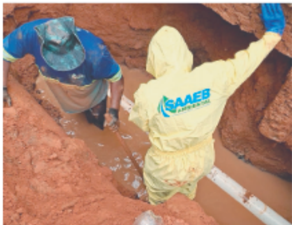
Restabelecendo - Equipe do Saab trabalha para restabelecer o abastecimento de água e reparar os danos causados pelo temporal em Bebedouro.
