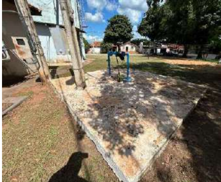
Figura 4-185 Vista da laje sanitária do poço Turvina
