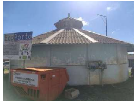
Figura 4-402 Vista do Reservatório Centro
