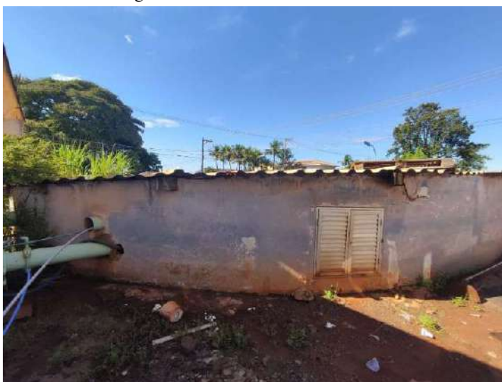
Figura 5-38. Reservatório 2 da ETA I.
