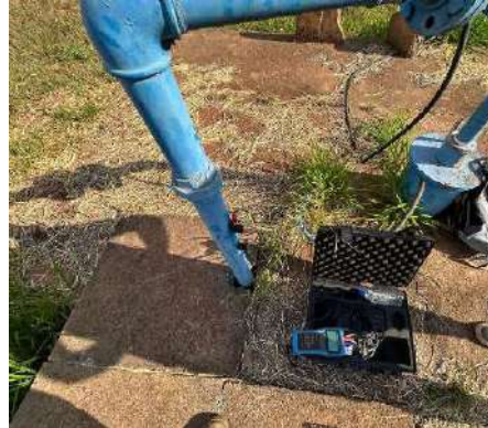
Figura 3-115. Medição de Vazão – Poço Hospital Julia.
