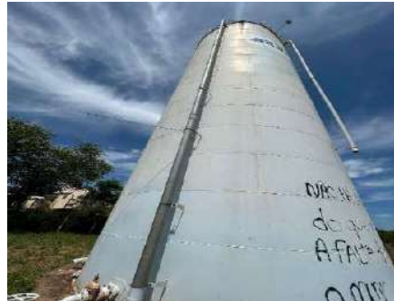
Figura 4-348 Continuação da tubulação de entrada
