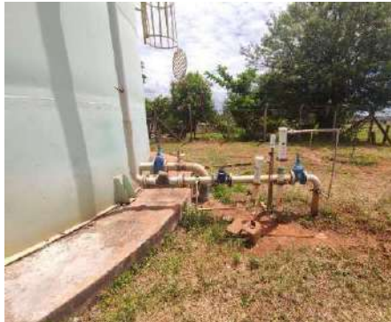
Figura 4-331 Continuação do poço SetJardim
