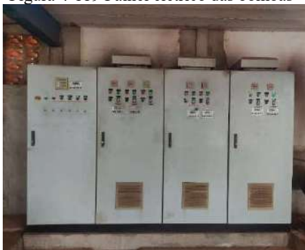
Figura 4-119 Painel elétrico das bombas
