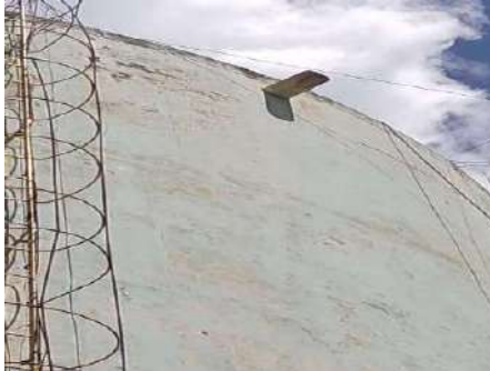
Figura 4-251 Extravasor da câmara alta do reservatório Progresso Alto/Baixo
