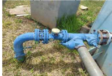
Figura 4-334 Vista da continuação do poço Souza Lima
