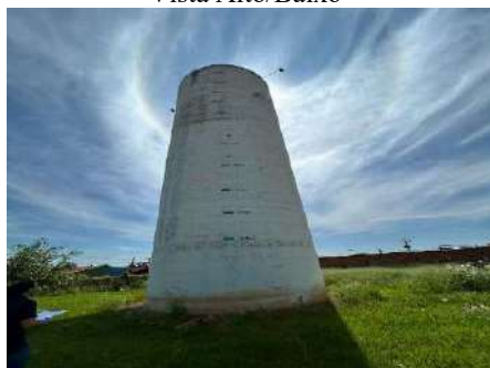
Figura 4-355 Vista do reservatório Boa Vista Alto/Baixo
