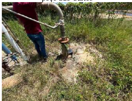
Figura 4-308 Vista da laje sanitária do poço São Carlos
