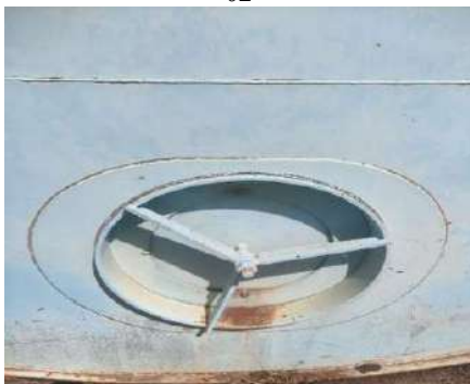
Figura 4-135 Tampa de acesso para limpeza do reservatório São Carlos ETA 02
