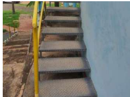
Figura 4-274 Vista da escada para acesso ao Reservatório Sanderson
