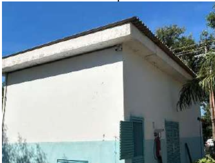
Figura 4-271 Vista sistema de monitoramento por câmeras
