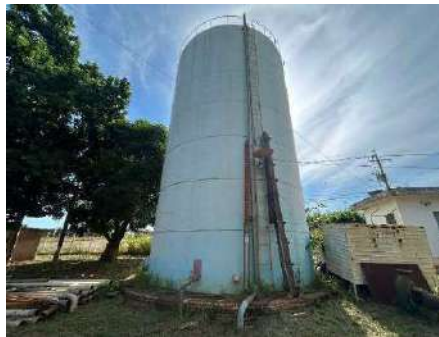
Figura 4-394 Tubulação de entrada do reservatório Jordana 500m 3
