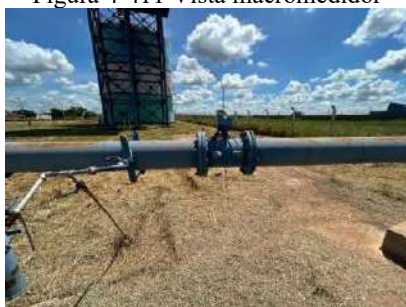
Figura 4-411 Vista macromedidor
