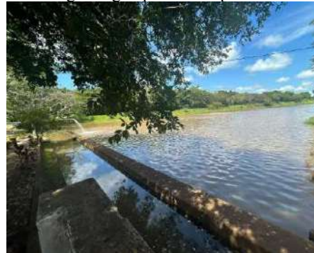
Figura 4-18 Vista do canal por onde a água segue para ser captada
