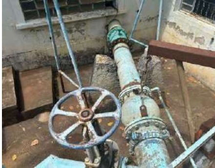
Figura 4-25 Vista tubulação de recalque dos conjuntos motor-bombas
