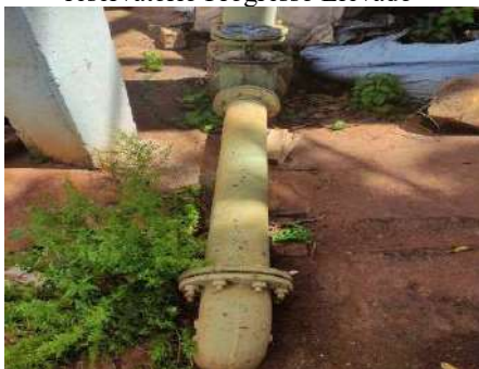
Figura 4-245 Tubulação de saída do reservatório Progresso Elevado
