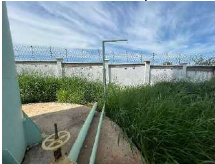
Figura 4-207 Vista do extravasor do reservatório Europa
