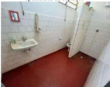
Figura 4-51. Vista do banheiro para os operadores da captação
