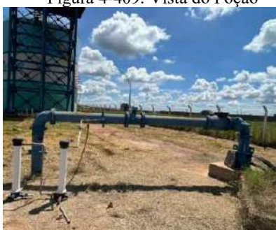
Figura 4-409. Vista do Poço
