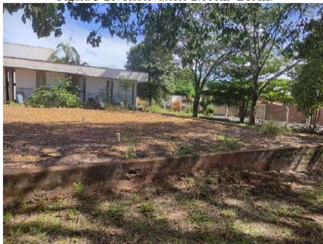
Figura 5-20. Reservatório 2.000m 3 ETAIL.
