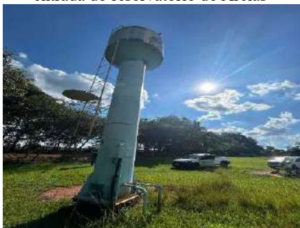
Figura 4-181 Vista da tubulação de entrada do reservatório de Areias
