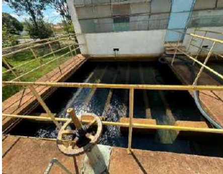
Figura 4-101 Vista do filtro 03 da ETA 02
