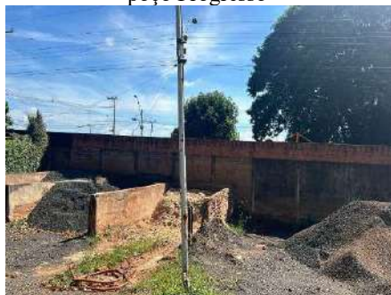
Figura 4-238 Vista do armazenamento de matérias de construção civil próxima do poço Progresso
