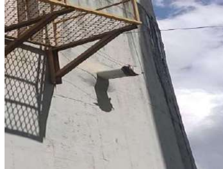
Figura 4-252 Extravasor da câmara baixa do reservatório Progresso Alto/Baixo
