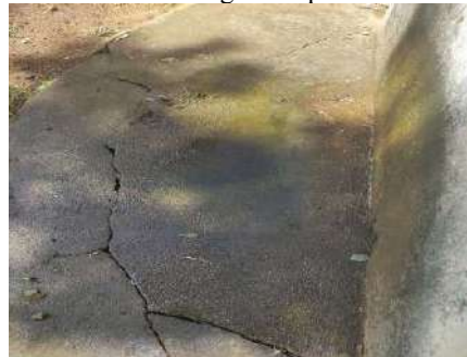
Figura 4-162 Vazamento do reservatório Botafogo Campo
