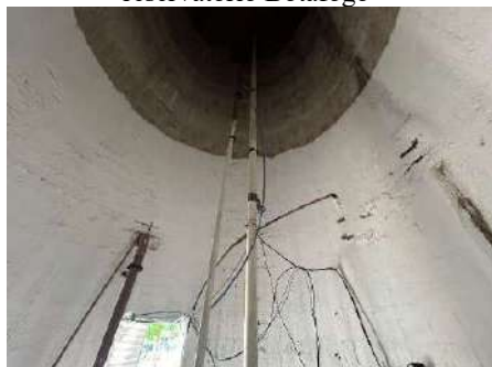
Figura 4-157 Tubulação de saída do reservatório Botafogo
