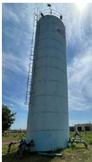
Figura 5-71. Reservatório Souza Lima (RSL).
