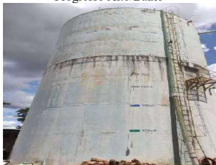
Figura 4-250 Vista do reservatório Progresso Alto/Baixo
