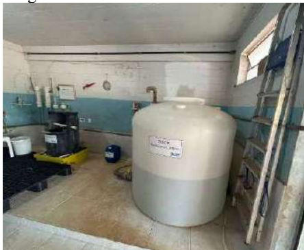
Figura 4-107. Armazenamento de flúor
