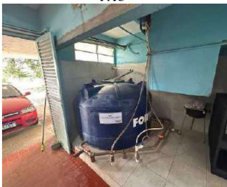
Figura 4-109 Vista do armazenamento de PAC
