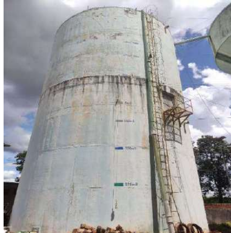
Figura 5-99. Reservatório Progresso – Câmara Dupla.
