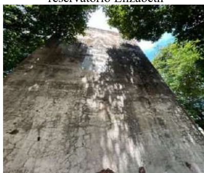
Figura 4-146 Vista da parede lateral do reservatório Elizabeth
