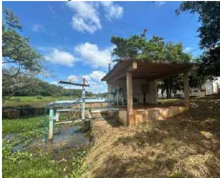
Figura 4-15 Vista Casa de abrigo do conjunto motor-bomba
