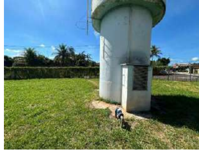
Figura 4-292 Vista do painel elétrico do poço Julia Velho
