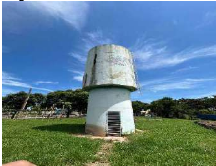
Figura 4-293 Vista do reservatório Julia
