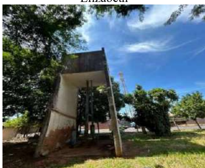
Figura 4-145 Vista frontal do reservatório Elizabeth
