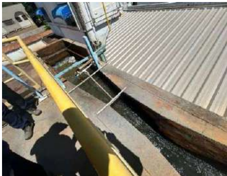
Figura 4-55 Vista da chegada da água bruta e a Calha Parshall
