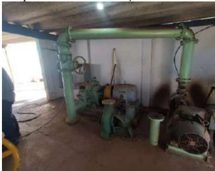
Figura 4-83 Vista dos conjuntos motor-bombas B03 e B04 que recalcam água para o Sistema de Poço e Centro
