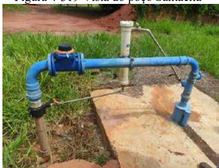
Figura 4-319 Vista do poço Santaella
