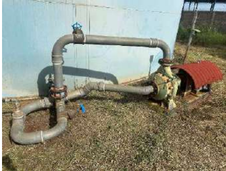
Figura 4-383 Tubulação de saída com bombeamento
