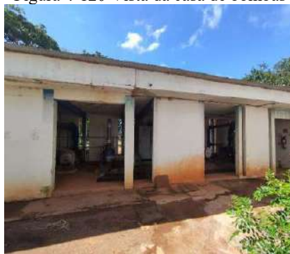
Figura 4-120 Vista da casa de bombas
