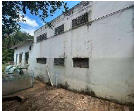
Figura 4-32 Vista da entrada da captação CAP 01
