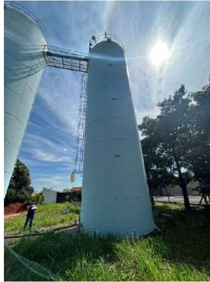
Figura 5-34. Reservatório Torre Gêmeas 02.
