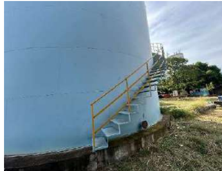
Figura 4-382 Vista das escadas de acesso do reservatório Jordana 1.000m 3
