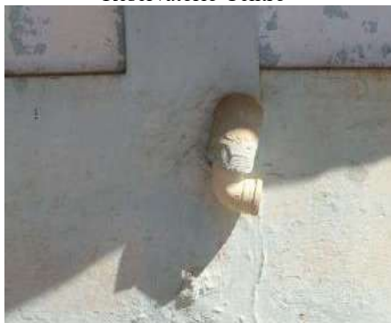
Figura 4-405 Vista do extravasor do Reservatório Centro
