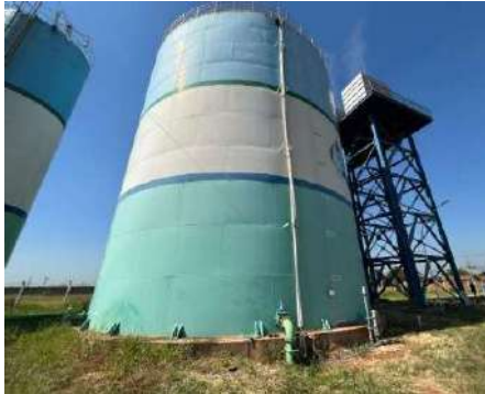
Figura 3-42. Vista do local de medição de vazão – Reservatório 2.000m 3
