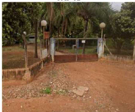
Figura 4-54 Vista da entrada da captação CAP 02
