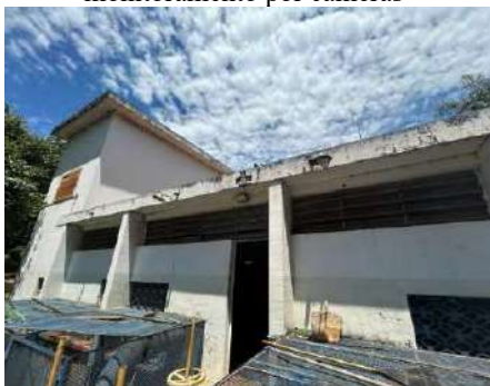
Figura 4-49 Vista do sistema de monitoramento por câmeras
