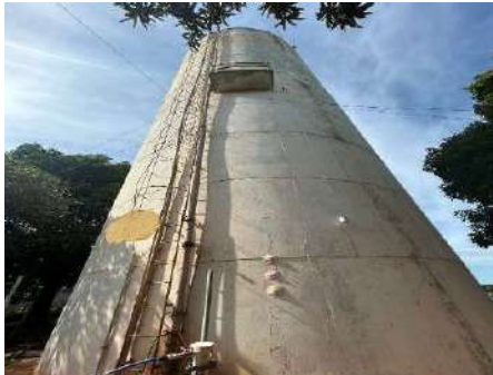
Figura 4-387 Vista do reservatório Jordana Alto/Baixo
