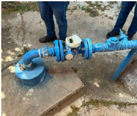
Figura 3-138. Vista do local de medição de vazão – Poço Andes.
