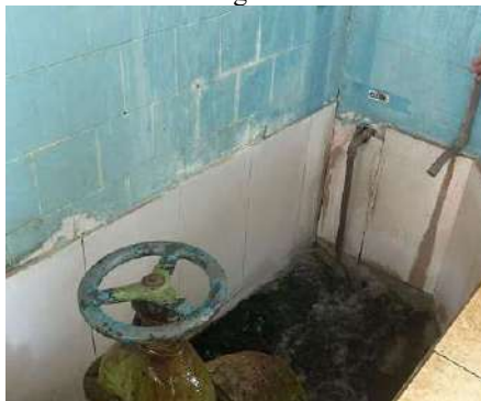
Figura 4-68 Dosagem de cloro e flúor na saída da água filtrada
