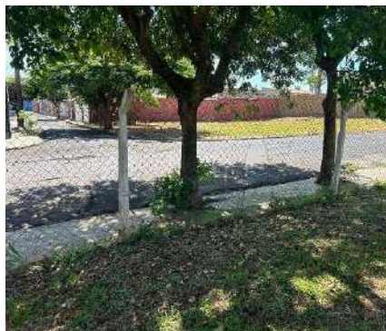
Figura 4-304 Vista do alambrado com buraco
