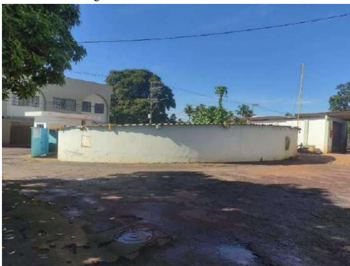
Figura 5-37. Reservatório 1 da ETA I.
