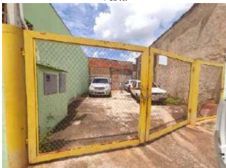
Figura 4-353 Vista do portão do poço Boa Vista
