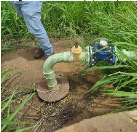
Figura 4-203 Vista do poço Europa
