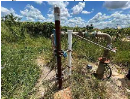
Figura 4-305 Vista do poço São Carlos
