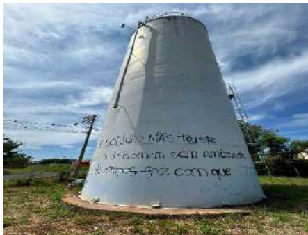
Figura 4-349 Vista do extravasor do reservatório do Jardim Itália
