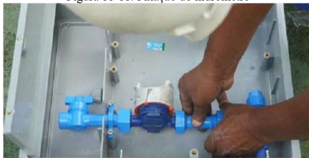
Figura 10-16. Fixação do hidrômetro
