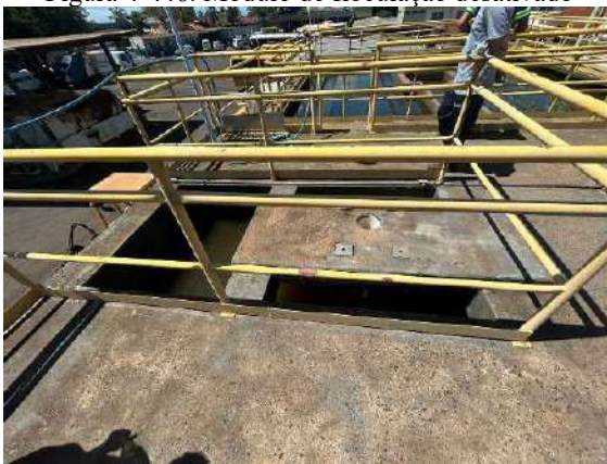
Figura 4-446. Módulo de floculação desativado
