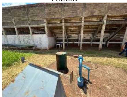
Figura 4-314 Vista do local do poço FECCIB
