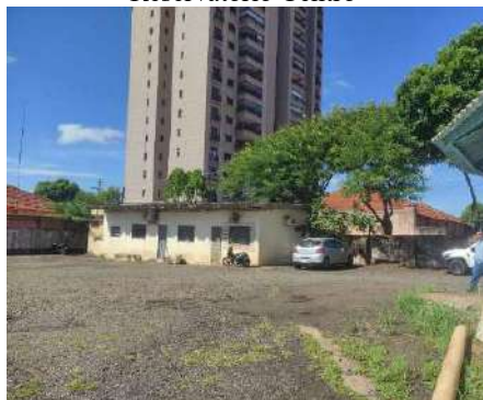
Figura 4-406 Vista em torno do Reservatório Centro
