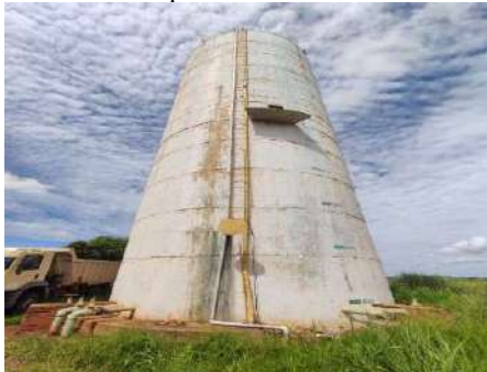
Figura 4-281 Vista do reservatório Tropical Alto/Baixo
