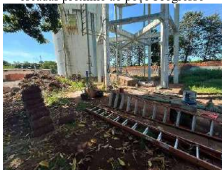
Figura 4-242 Vista da vegetação e escadas próximo ao poço Progresso
