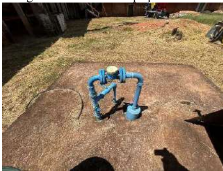
Figura 4-311 Vista do poço FECCIB
