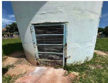
Figura 4-294 Vista da porta de acesso do reservatório Julia
