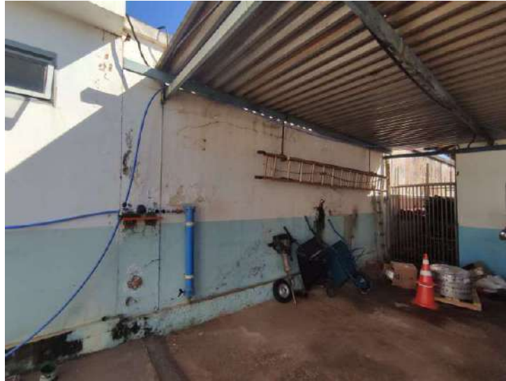
Figura 5-39. Reservatório Almojarifado da ETA I.
