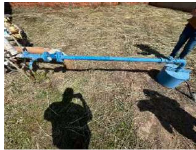
Figura 4-210 Vista lateral direita do poço Primavera
