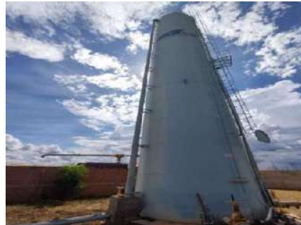
Figura 4-214 Vista do extravasor do reservatório Primavera
