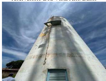
Figura 4-356 Escada de acesso do reservatório Boa Vista Alto/Baixo
