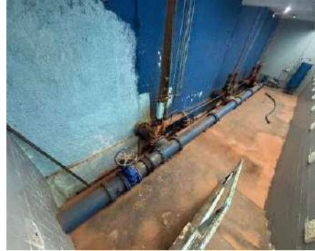
Figura 4-106 Registro de Ø200mm com vazamento
