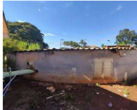
Figura 4-80 Vista do reservatório Caixa II ETA 01
