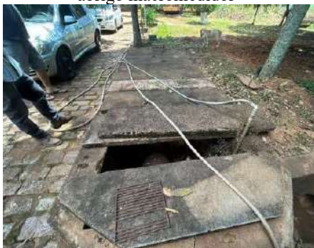
Figura 4-47 Vista da possível caixa de abrigo macromedidor
