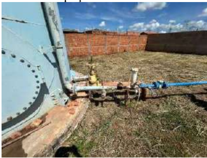
Figura 4-209 Vista lateral esquerda do poço Primavera
