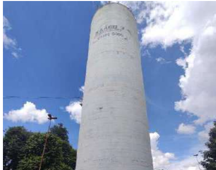
Figura 3-46. Vista do local de medição de vazão – Reservatório Alto Claudia.
