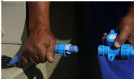
Figura 10-13. Conexões do ramal à entrada de água
