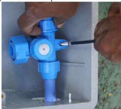
Figura 10-14. Fixação da conexão de entrada
