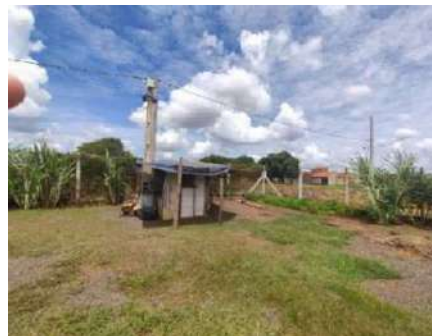
Figura 4-328 Abrigo do operador do poço SetJardim
