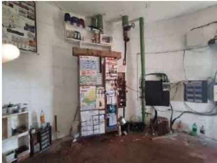
Figura 4-227 Vista interna do reservatório Cláudia Alto/Baixo
