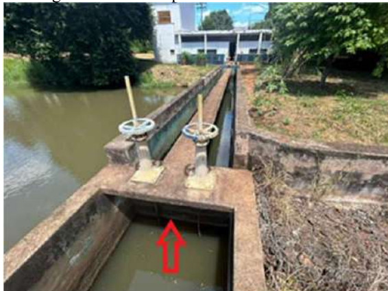
Figura 4-442. Comportas a serem substituídas
