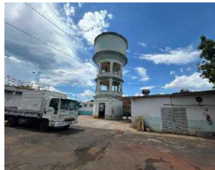
Figura 4-76 Vista do reservatório Torre ETA 01
