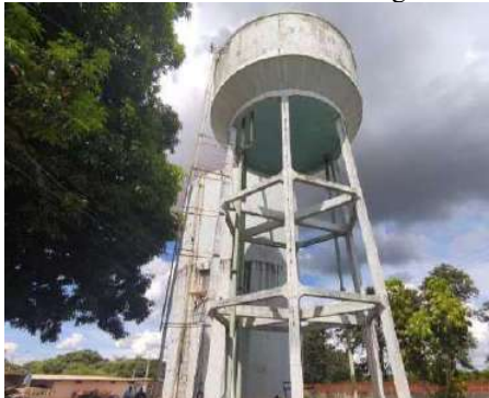
Figura 3-70. Vista do local de medição de vazão – Reservatório Elevado Progresso.
