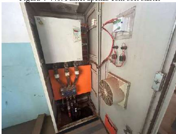
Figura 4-440. Painel apenas com soft starter
