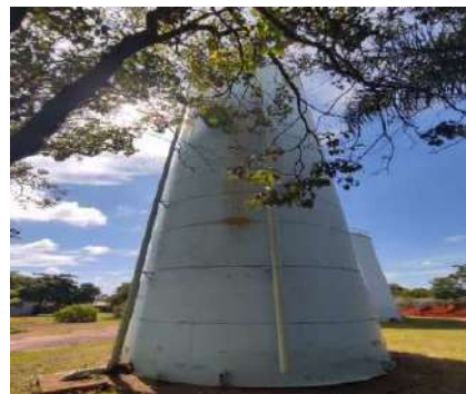
Figura 4-136 Escada de acesso para o reservatório São Carlos ETA 02
