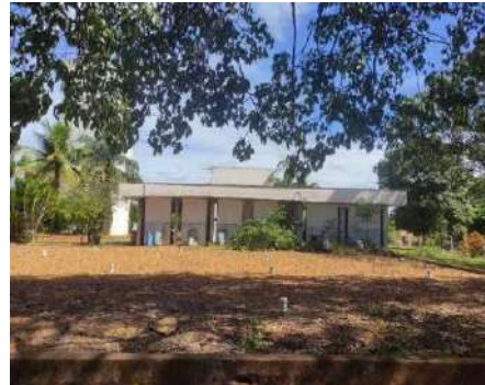
Figura 4-116 Vista do abrigo dos conjuntos motor-bombas B01, B02, B03, B04 e B05
