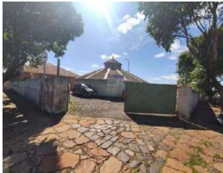
Figura 4-401 Portão de acesso ao local do Reservatório Centro
