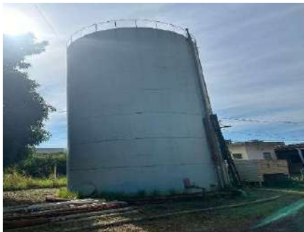
Figura 4-393 Vista do reservatório Jordana 500m 3
