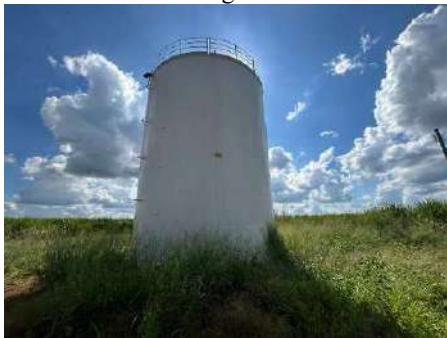
Figura 4-199 Vista do reservatório Portal do Lago 02
