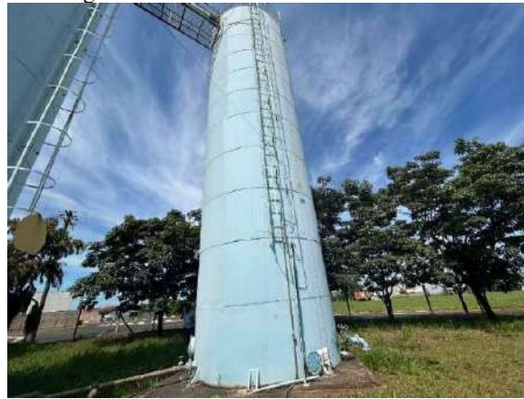
Figura 5-31. Reservatório Torre Gêmeas 01.
