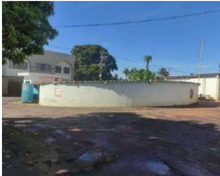
Figura 4-79. Vista do reservatório Caixa I ETA 01
