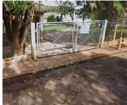
Figura 4-34 Vista portão de acesso da captação CAP 01
