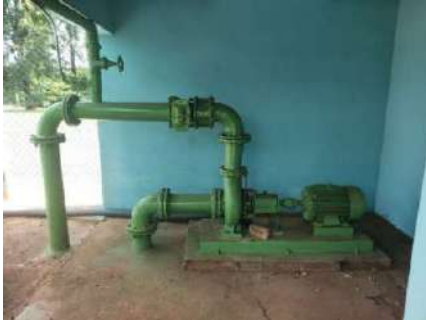
Figura 4-269. Vista de conjunto moto-bomba que recalca água para o Reservatório do Progresso
