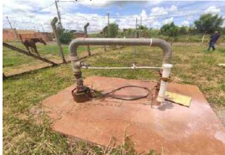
Figura 4-333 Vista do e da laje sanitária do poço Souza Lima
