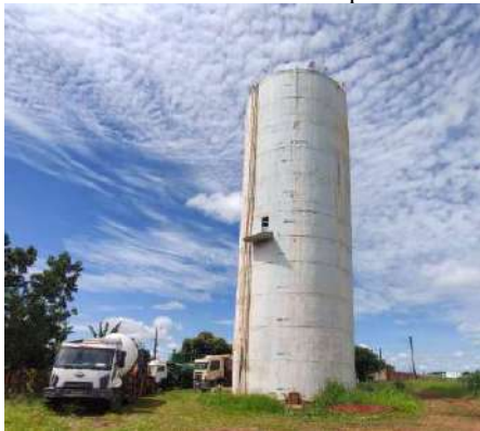
Figura 3-94. Vista do local de medição de vazão – Reservatório Tropical.
