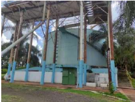
Figura 4-265 Vista do Reservatório Sanderson.
