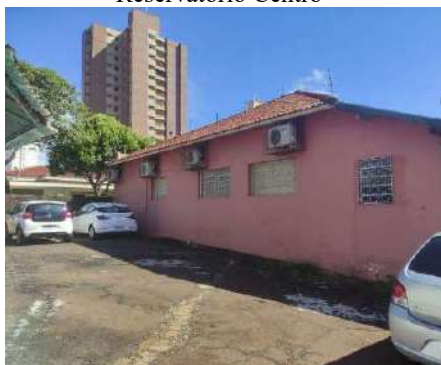
Figura 4-407 Vista entorno do Reservatório Centro
