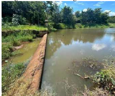
Figura 4-36 Vista Córrego do Retiro
