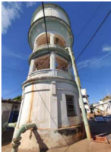
Figura 5-45. Reservatório Torre da ETA I.
