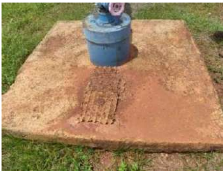
Figura 4-327 Laje sanitária do poço SetJardim
