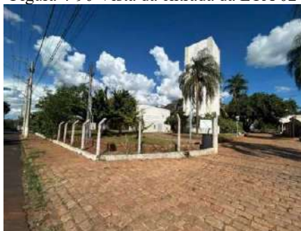
Figura 4-90 Vista da entrada da ETA 02
