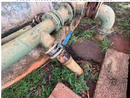
Figura 4-389 Tubulação de saída do reservatório Jordana Alto/Baixo
