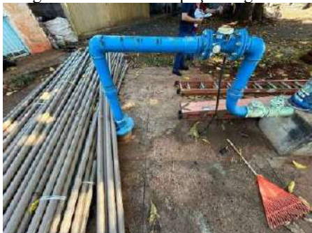
Figura 4-233 Vista do poço Progresso
