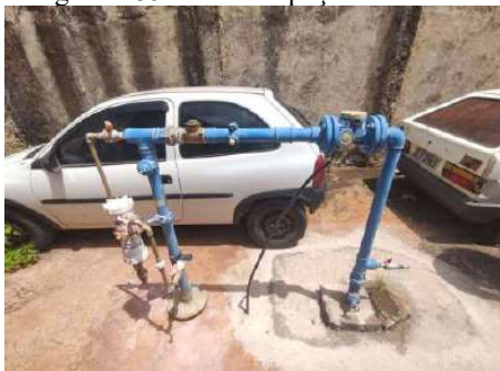
Figura 4-351 Vista do poço Boa Vista
