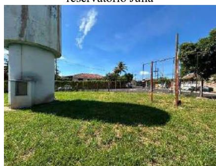
Figura 4-298 Vista do em torno do reservatório Julia
