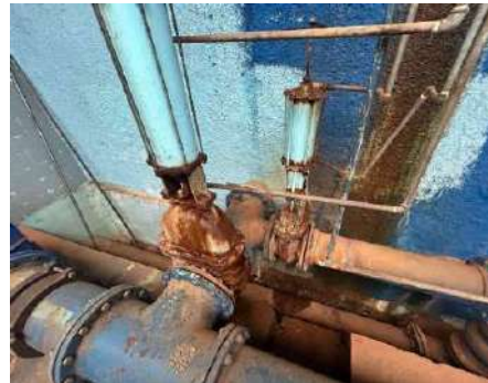
Figura 4-106 Registro de Ø200mm com vazamento
