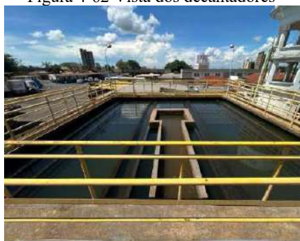
Figura 4-62 Vista dos decantadores
