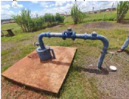
Figura 4-325 Vista do poço SetJardim
