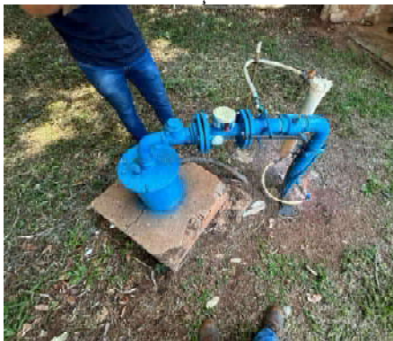
Figura 3-118. Vista do local de medição de vazão – Poço Elizabeth.
