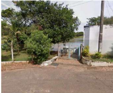
Figura 4-33 Vista portão de acesso da captação CAP 01
