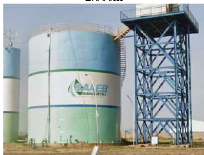
Figura 4-414 Vista do Reservatório 2.000m 3
