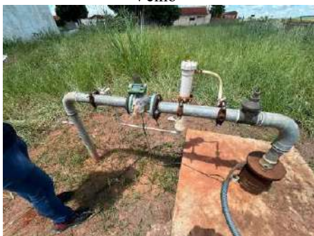
Figura 4-277 Vista do poço Tropical Velho
