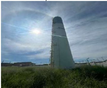
Figura 4-205 Vista do reservatório e tubulações de saída
