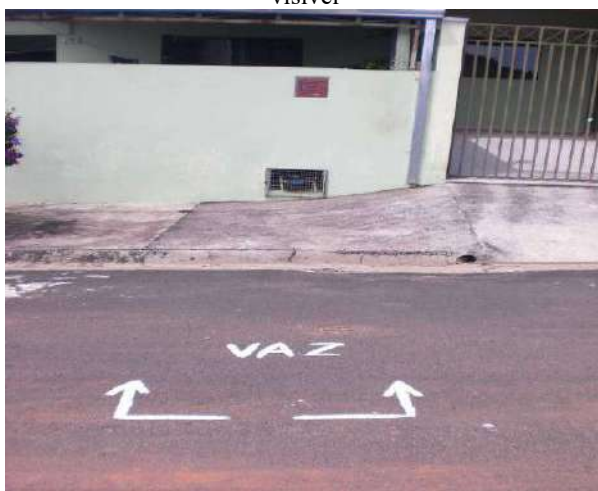
Figura 8-1 - Demarcação com tinta branca no local onde foi detectado vazamento não visível
