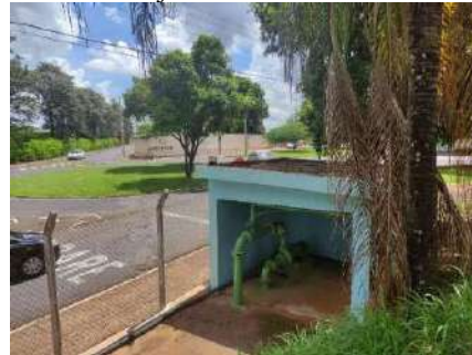
Figura 4-268 Vista casa de abrigo conjunto motor bomba
