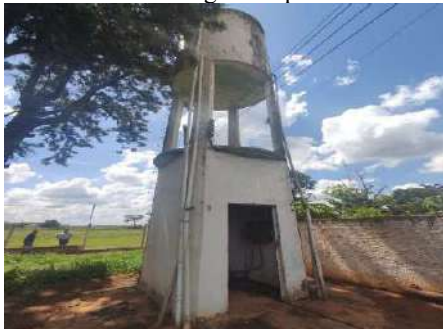
Figura 4-161 Vista frontal do reservatório Botafogo Campo
