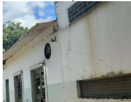
Figura 4-30 Vista sistema de monitoramento por câmeras
