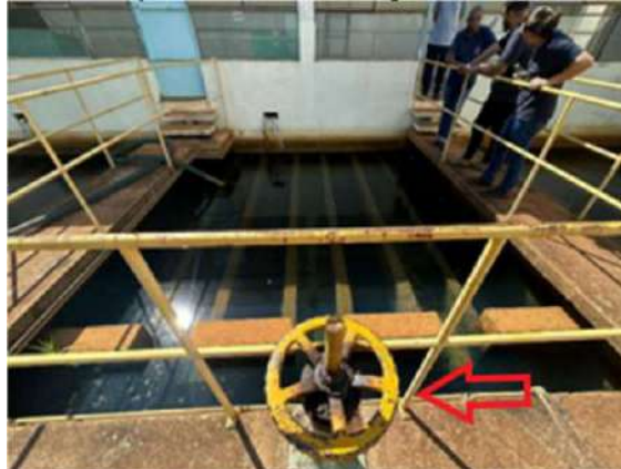
Figura 4-448. Registro de uma das comportas a serem substituídas
