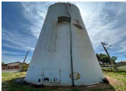
Figura 4-345 Vista do reservatório Jardim Itália
