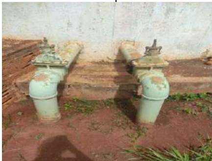
Figura 4-283 Vista da tubulação de saída do reservatório Tropical Alto/Baixo
