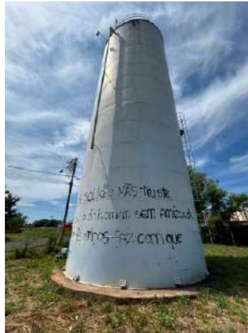
Figura 5-64. Reservatório Jardim Itália.
