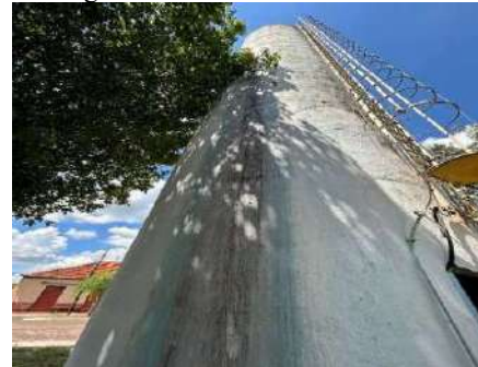
Figura 4-154 Vazamento externo
