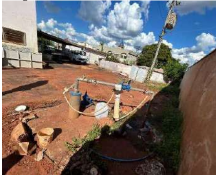
Figura 4-85 Vista do Pocinho ETA 01
