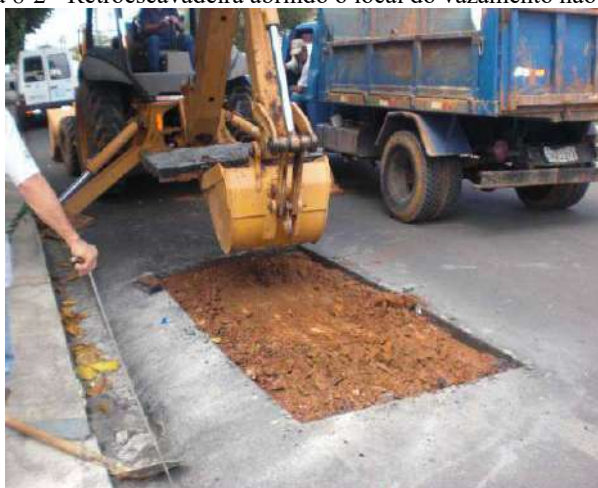
Figura 8-2 - Retroescavadeira abrindo o local do vazamento não visível
