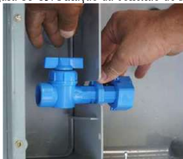
Figura 10-15. Fixação da conexão de saída
