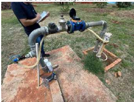
Figura 4-139 Vista frontal do poço ETA 02 Novo e da laje sanitária
