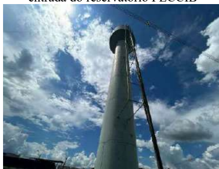
Figura 4-316 Vista da tubulação de entrada do reservatório FECCIB
