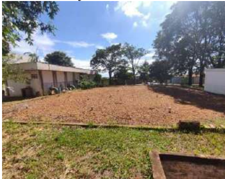
Figura 4-115 Vista superior do reservatório 2.000m 3 ETA 02 e do abrigo dos conjuntos motor-bomba
