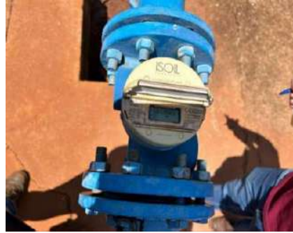
Figura 4-280 Vista do macromedidor de vazão do poço Tropical Novo
