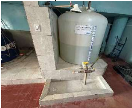
Figura 4-111 Vista da fabricação de hipoclorito
