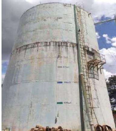
Figura 5-96. Reservatório Progresso – Câmara Dupla.
