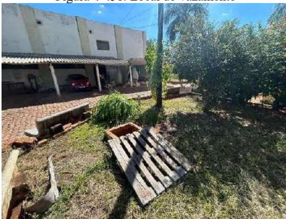
Figura 4-451. Local do vazamento
