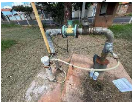
Figura 4-137 Vista do poço ETA 02 Velho com vazamento na mangueira
