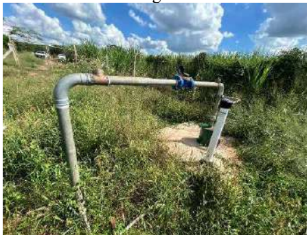
Figura 4-197 Vista frontal do poço Portal do Lago 02
