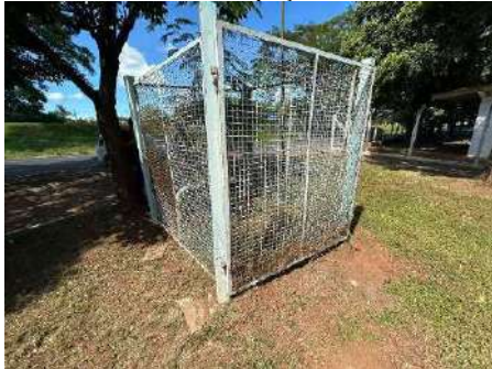
Figura 4-223 Vista lateral da grade de fechamento do poço Cláudia
