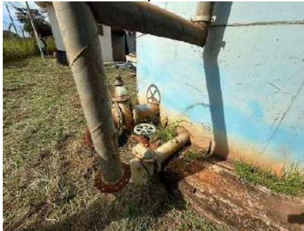
Figura 4-395 Extravasador e tubulação de limpeza
