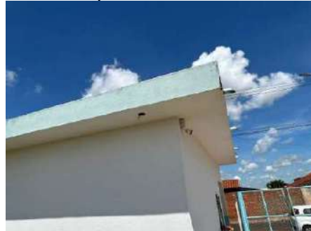
Figura 4-420 Vista do sistema de monitoramento por câmeras no Complexo Pedro Paschoal
