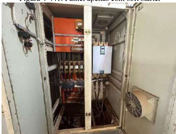
Figura 4-441. Painel apenas com soft starter
