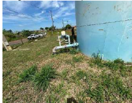
Figura 4-344 T tubulação de entrada
