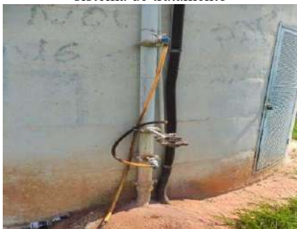
Figura 4-361 tubulação de entrada sem o sistema de tratamento
