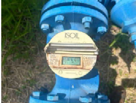
Figura 4-335 Macromedidor do poço Souza Lima
