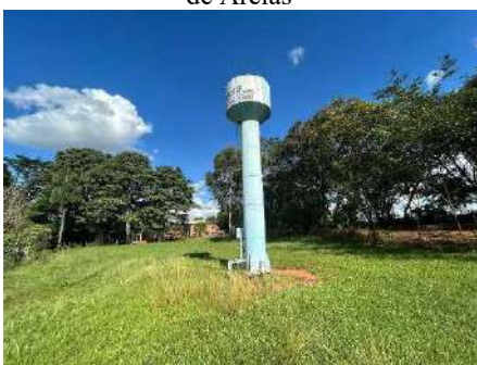
Figura 4-180 Vista frontal do reservatório de Areias
