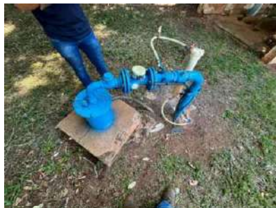
Figura 4-141 Vista elevada do poço Elizabeth
