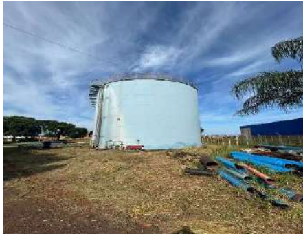
Figura 4-381 Vista do reservatório Jordana 1.000m 3
