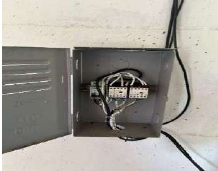
Figura 4-357 Disjuntor da válvula de retenção com defeito
